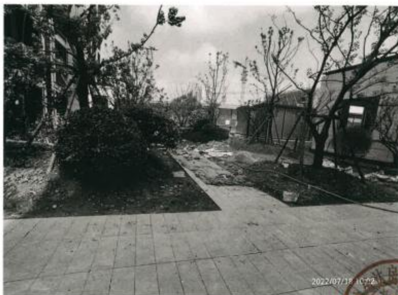
植物措施施工中
