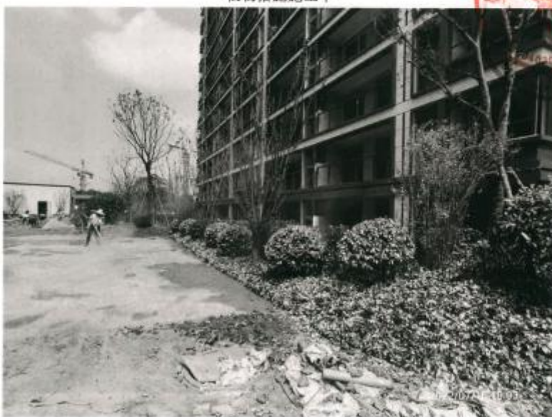
植物措施施工中
