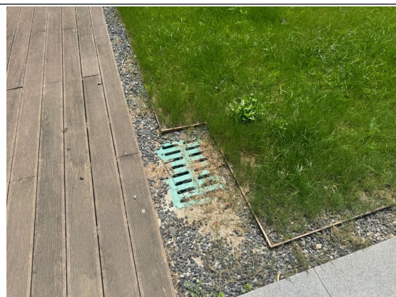
2025 年第二季度雨水口运行情况
