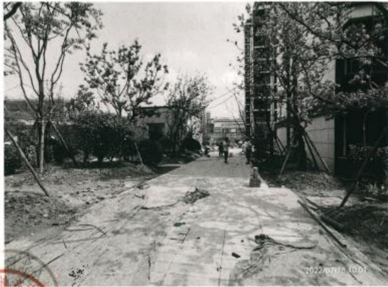
植物措施施工中
