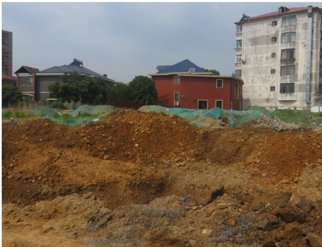
(施工过程中临时堆土重点监测部位)
