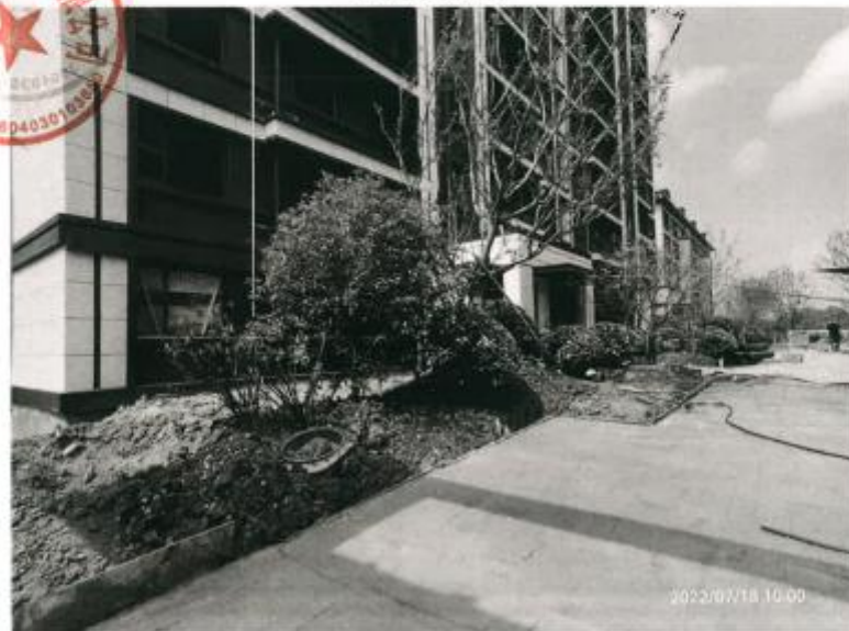
植物措施施工中
