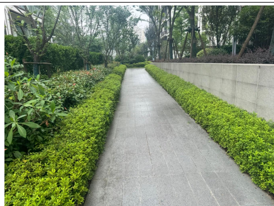
2025 年第三季度透水铺装运行情况
