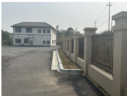
土桥泵站排水沟
