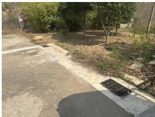
蛟滩泵站雨水口
