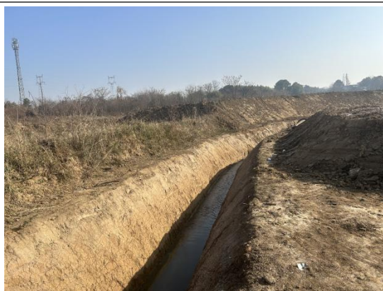
土桥泵站临时排水沟
