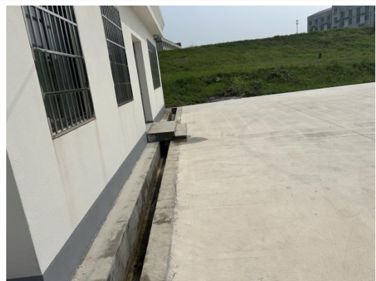
益公堤泵站管理房工程区排水沟
