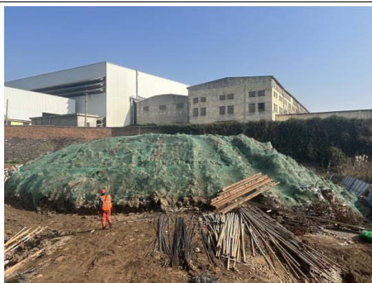
袁家湖泵站工程区苫布覆盖
