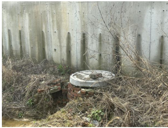
土桥泵站临时道路区雨水井
