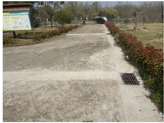
蛟滩泵站雨水口
