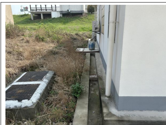
管理房工程区排水沟
