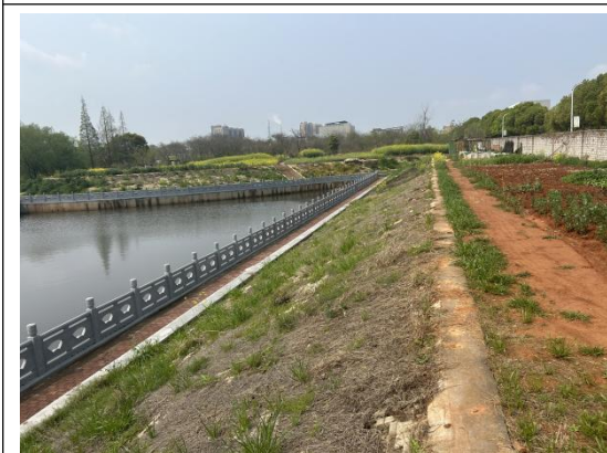
姬公庵泵站生态砼连锁块护坡
