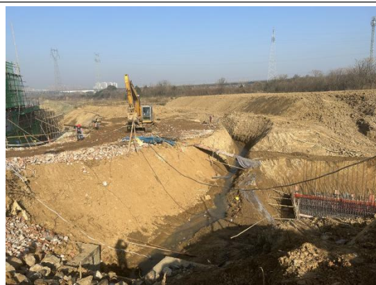
土桥泵站临时排水沟
