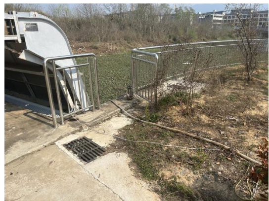
蛟滩泵站雨水口
