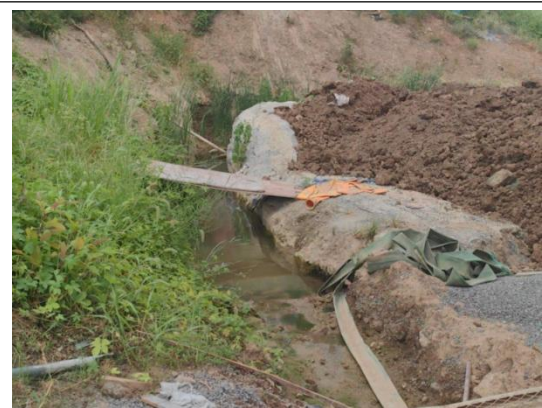
袁家湖泵站临时排水沟
