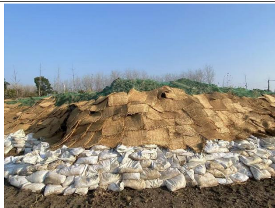
姬公庵泵站装土草袋挡墙
