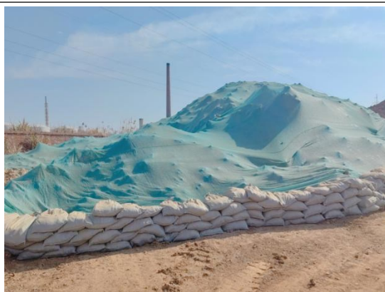
土桥泵站装土草袋挡墙
