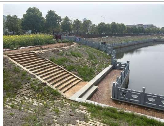
姬公庵泵站生态砼连锁块护坡
