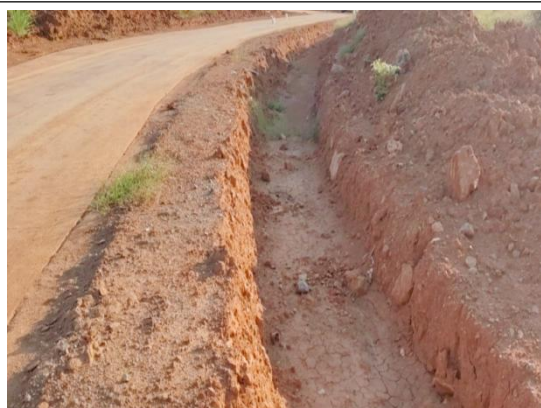
土桥泵站临时排水沟
