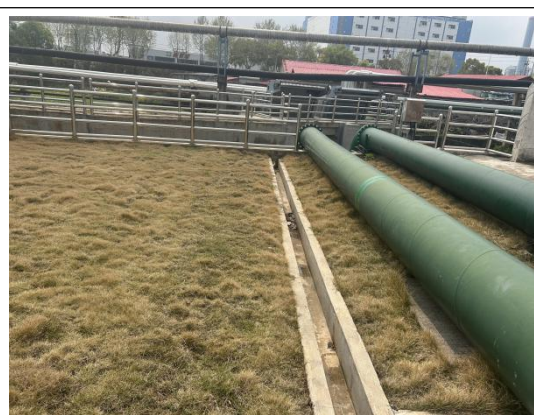
琵琶湖泵站排水沟
