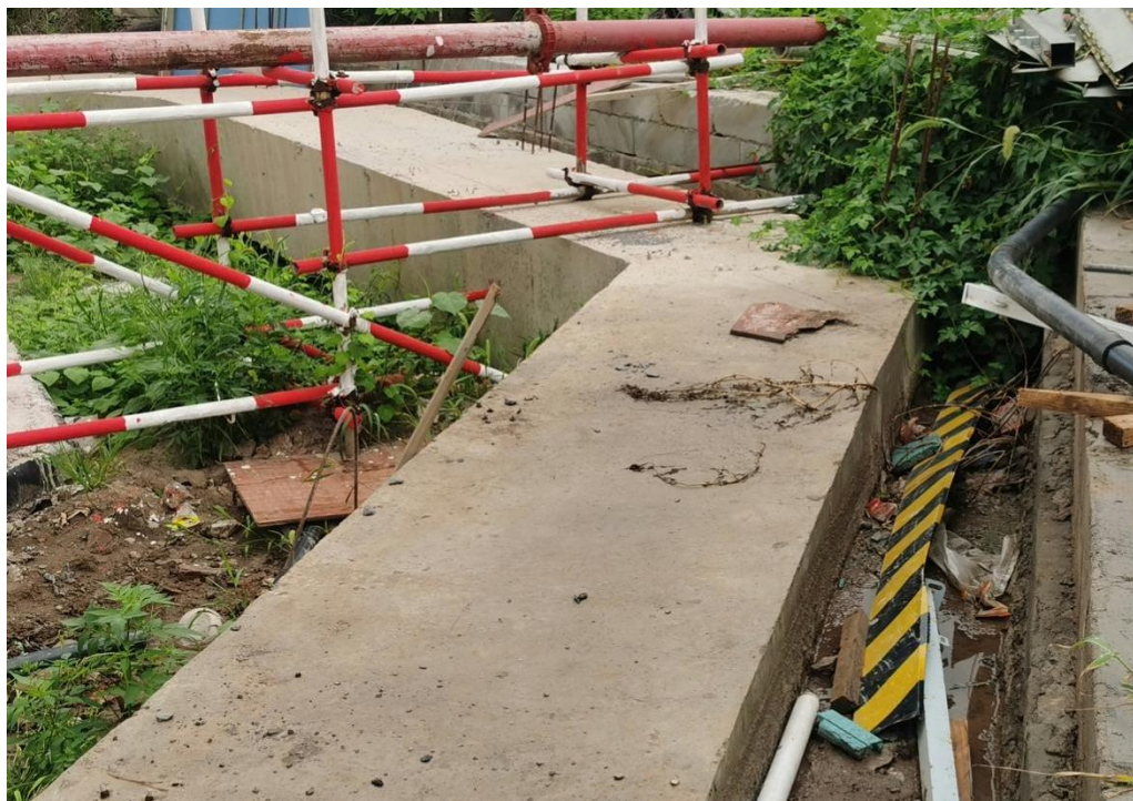
图 3-4 基坑截水沟现场照片
