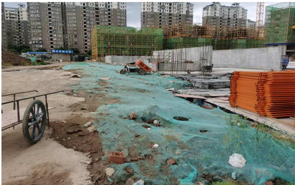
图 3-1 临时覆盖现场照片
