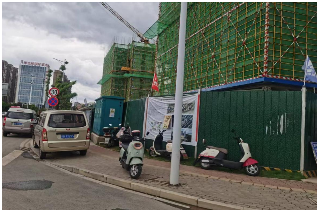
图 3-3 拦挡措施现场照片
