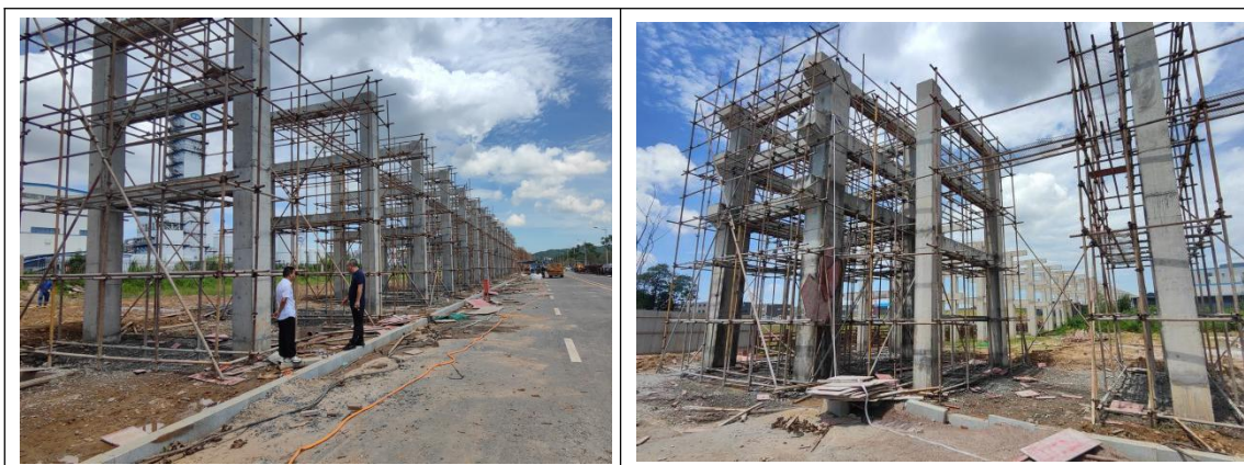
在建 4m 宽钢筋混凝土管架照片
