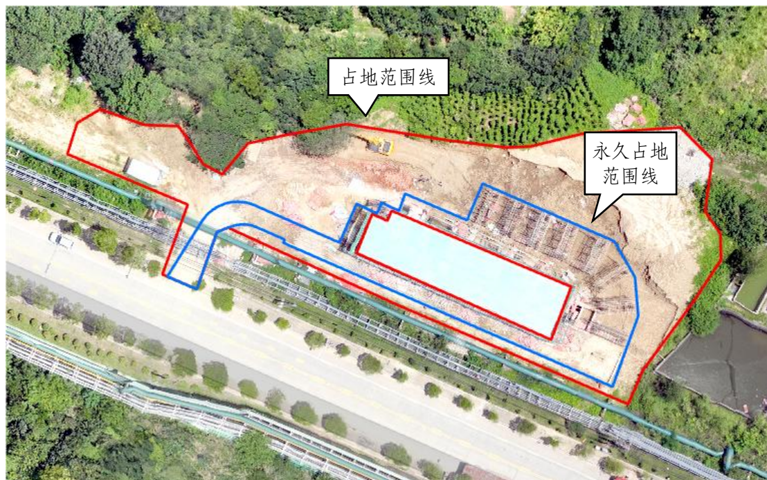
图 2.25 在线监测站房现状航拍图 (2025 年 7 月 1 日)
