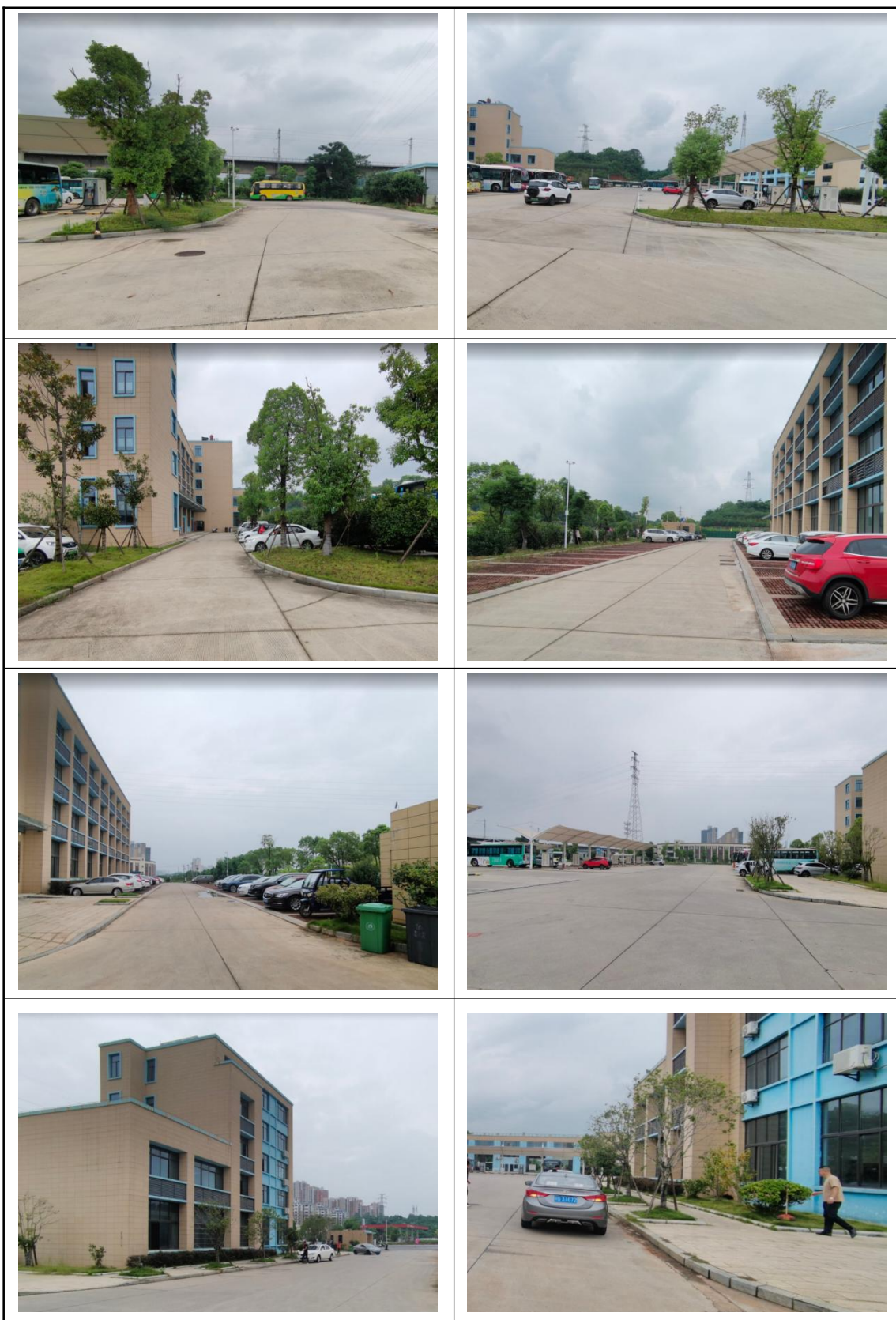
附件 7 重要水土保持单位工程照片
