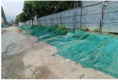
施工便道及苫布覆盖
