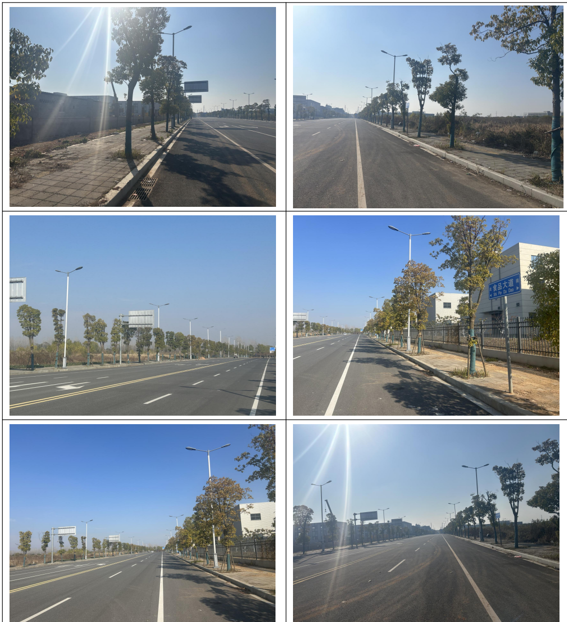
已完成水土保持设施情况
