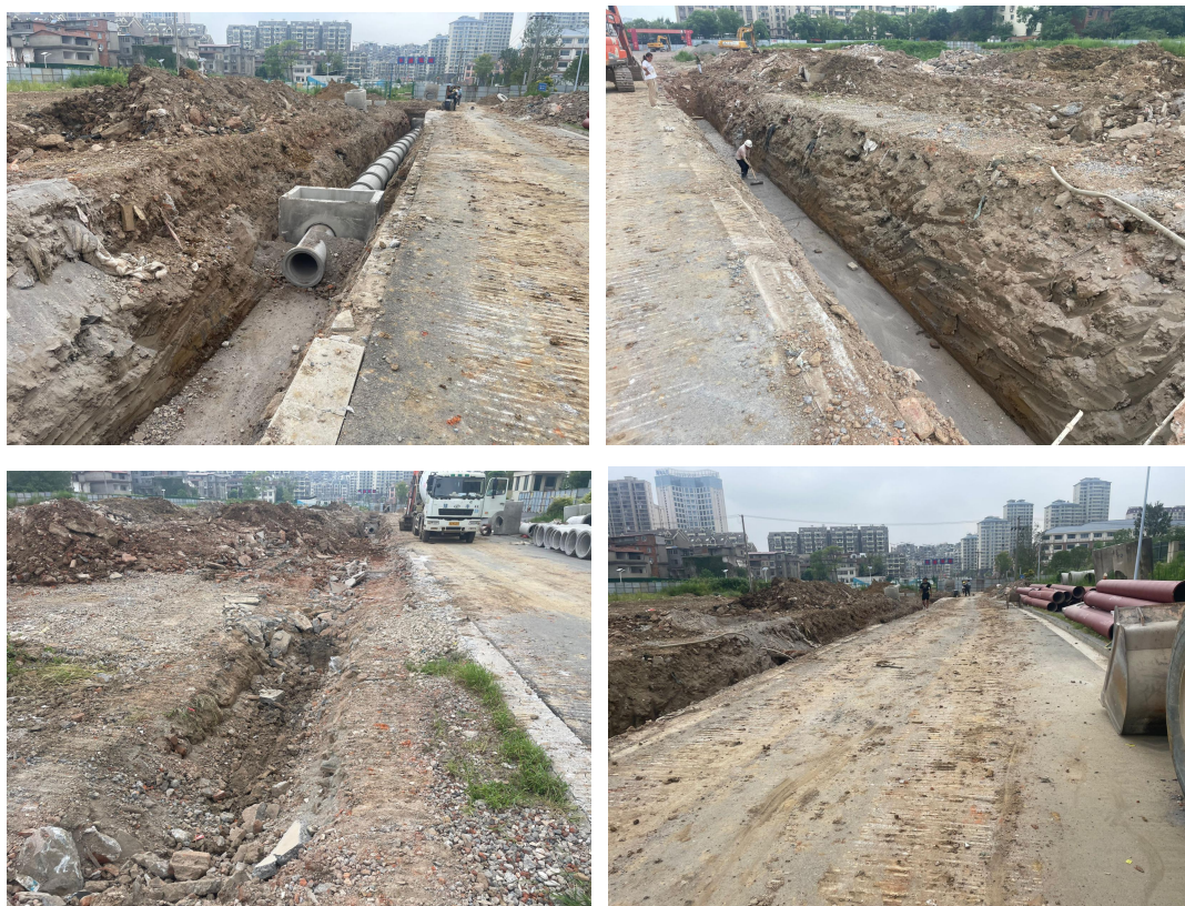
花园畈北侧道路左侧开挖并铺设污水管道
