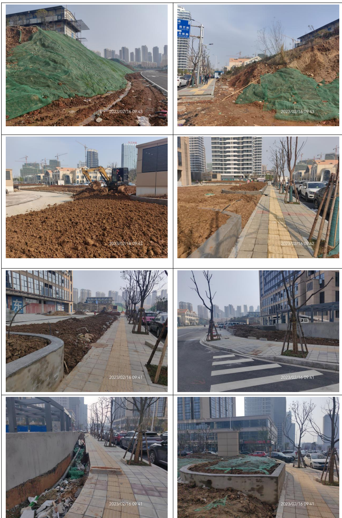
施工过程中水土保持设施影像资料
