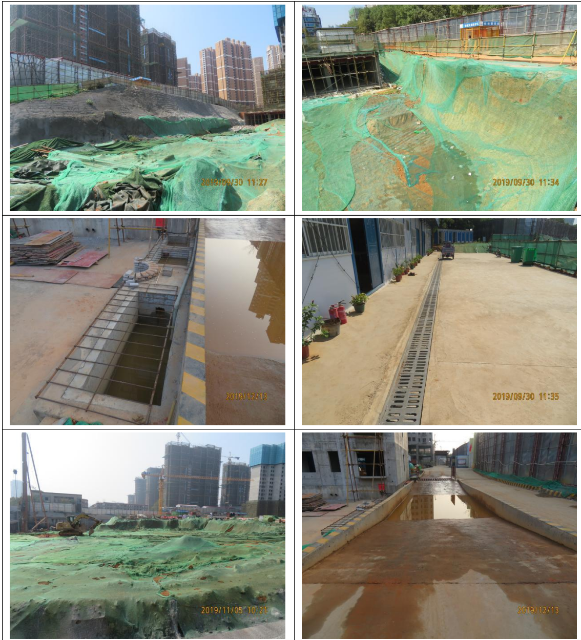
临时措施影像
