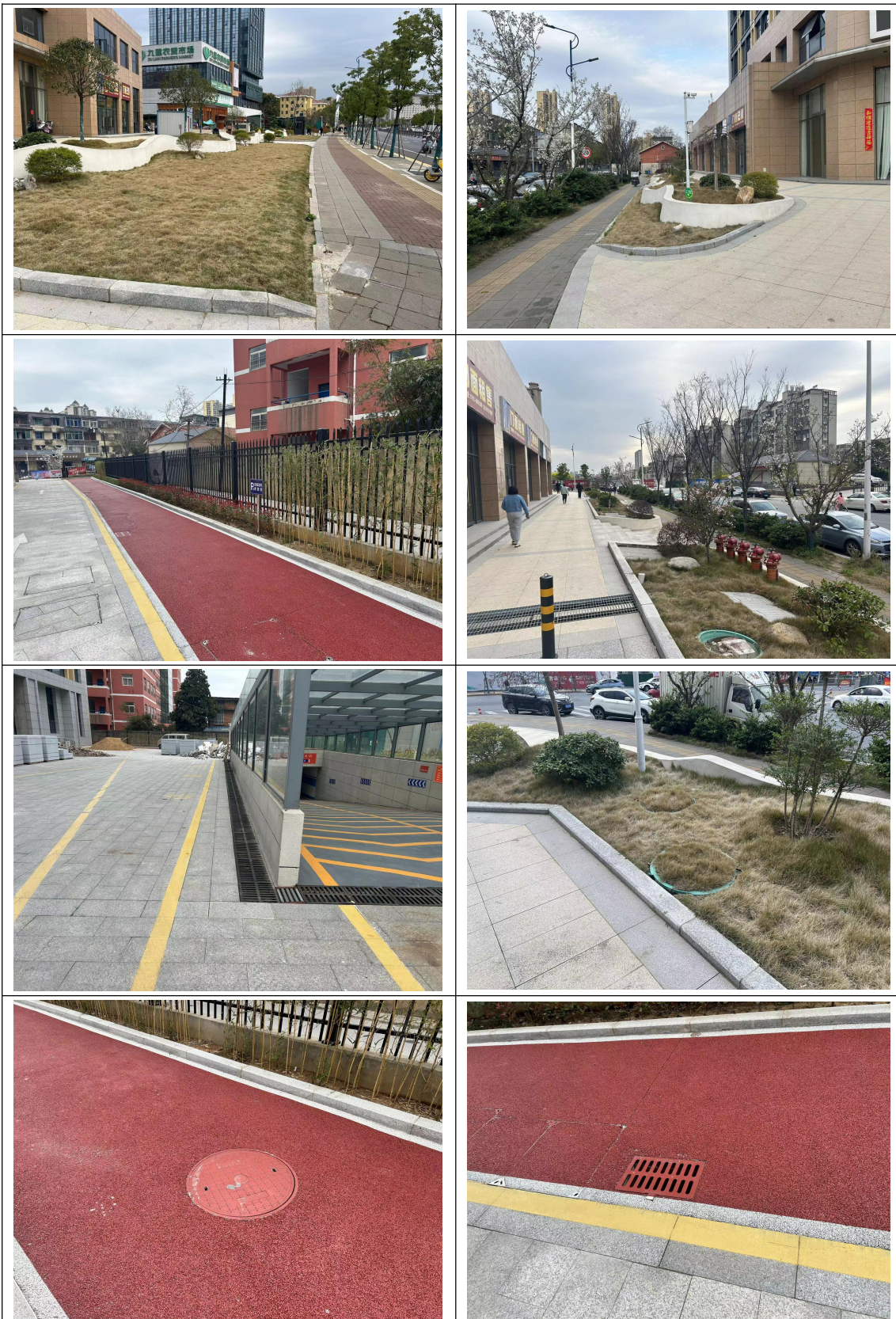
已完成水土保持设施情况
