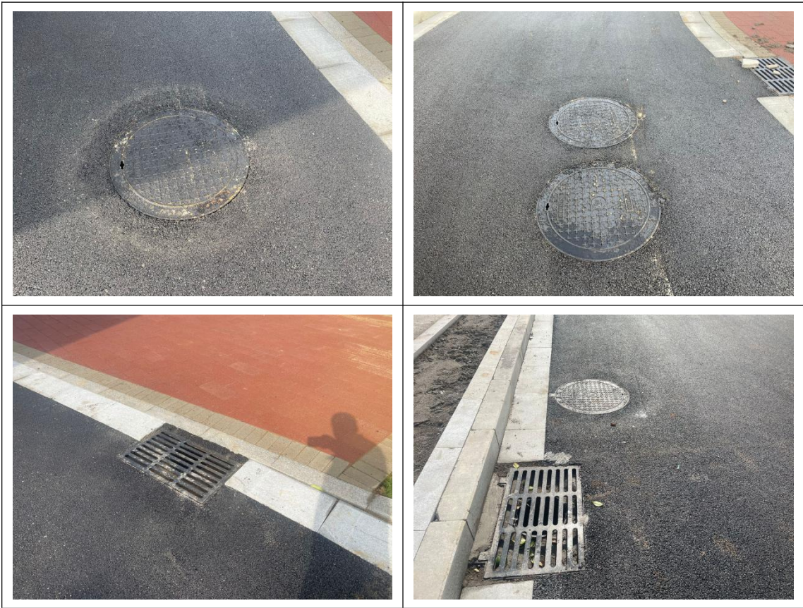
图 4.1-1 工程措施完成情况影像
