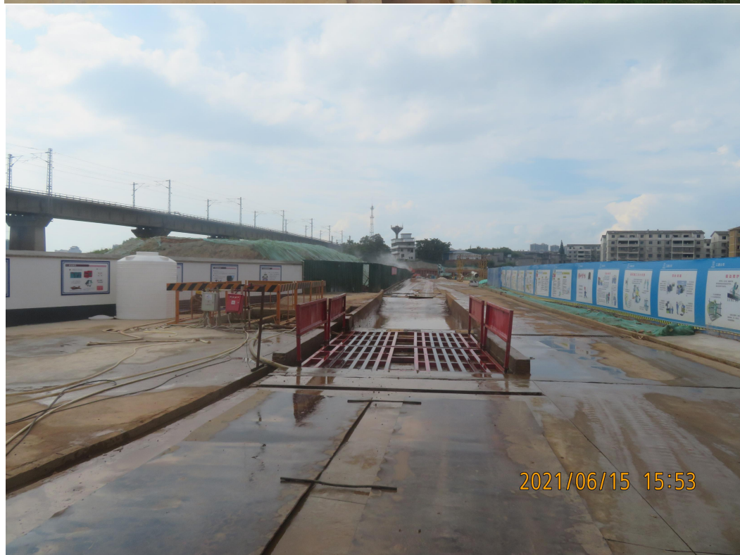
(施工过程中洗车槽、临时排水、沉沙池、覆盖等重点监测部位)
