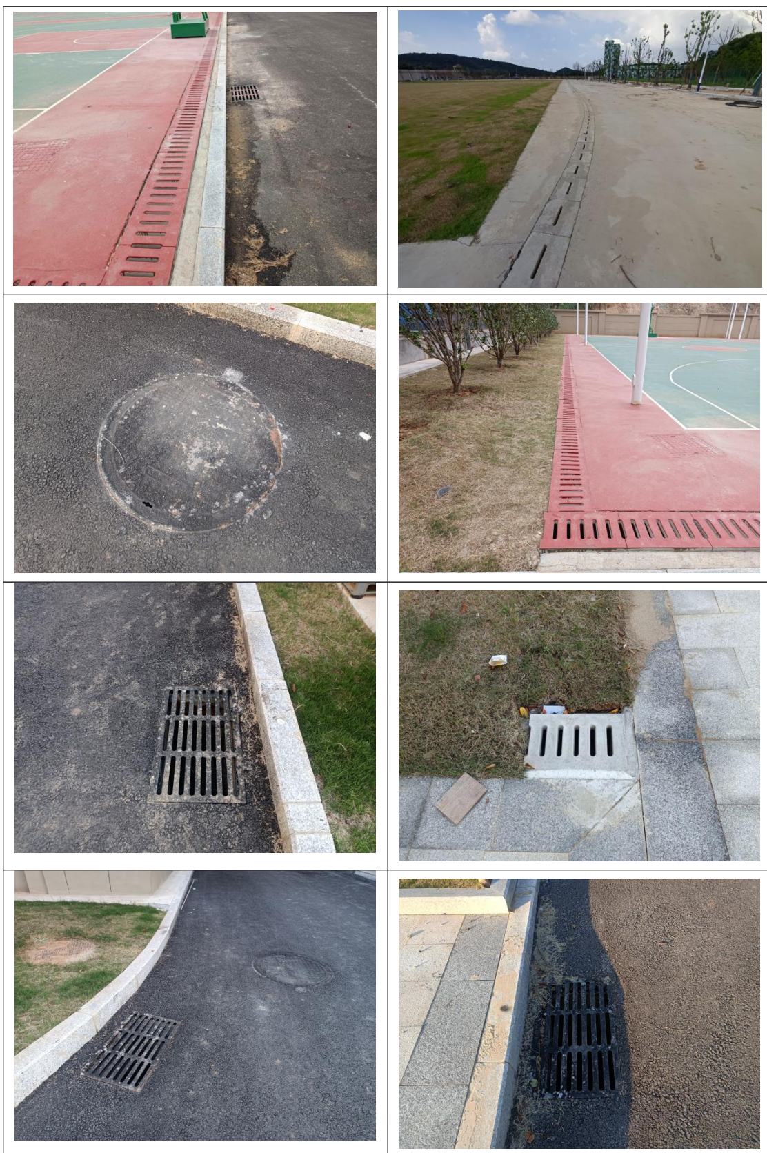
附件 6 重要水土保持单位工程照片
