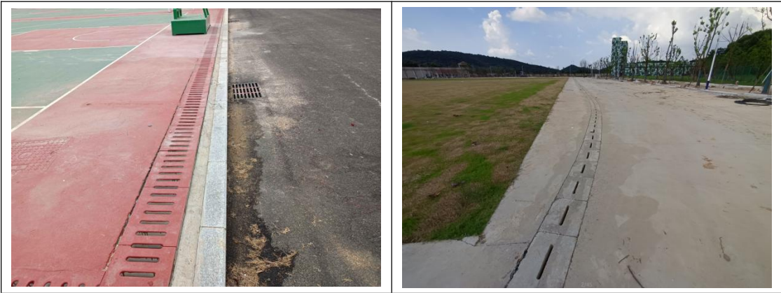
图 4.1-1 工程措施完成情况影像
