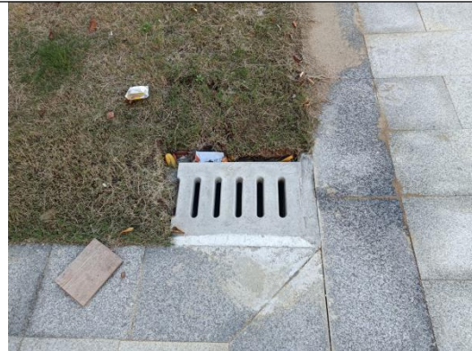
2023 年 12 月雨水口运行情况
