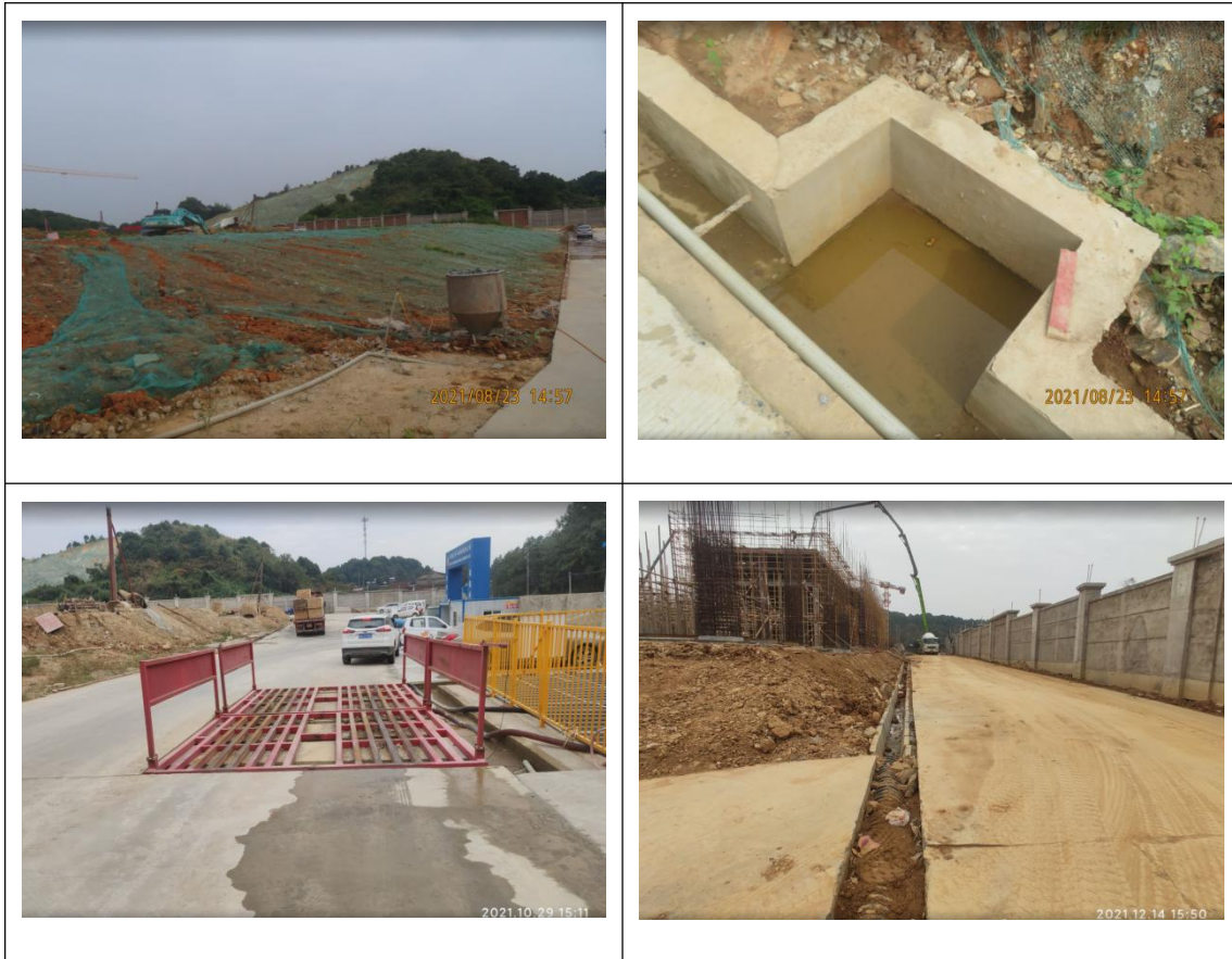
临时措施影像
