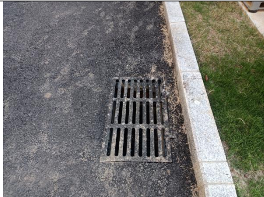
2023 年 12 月雨水口运行情况
