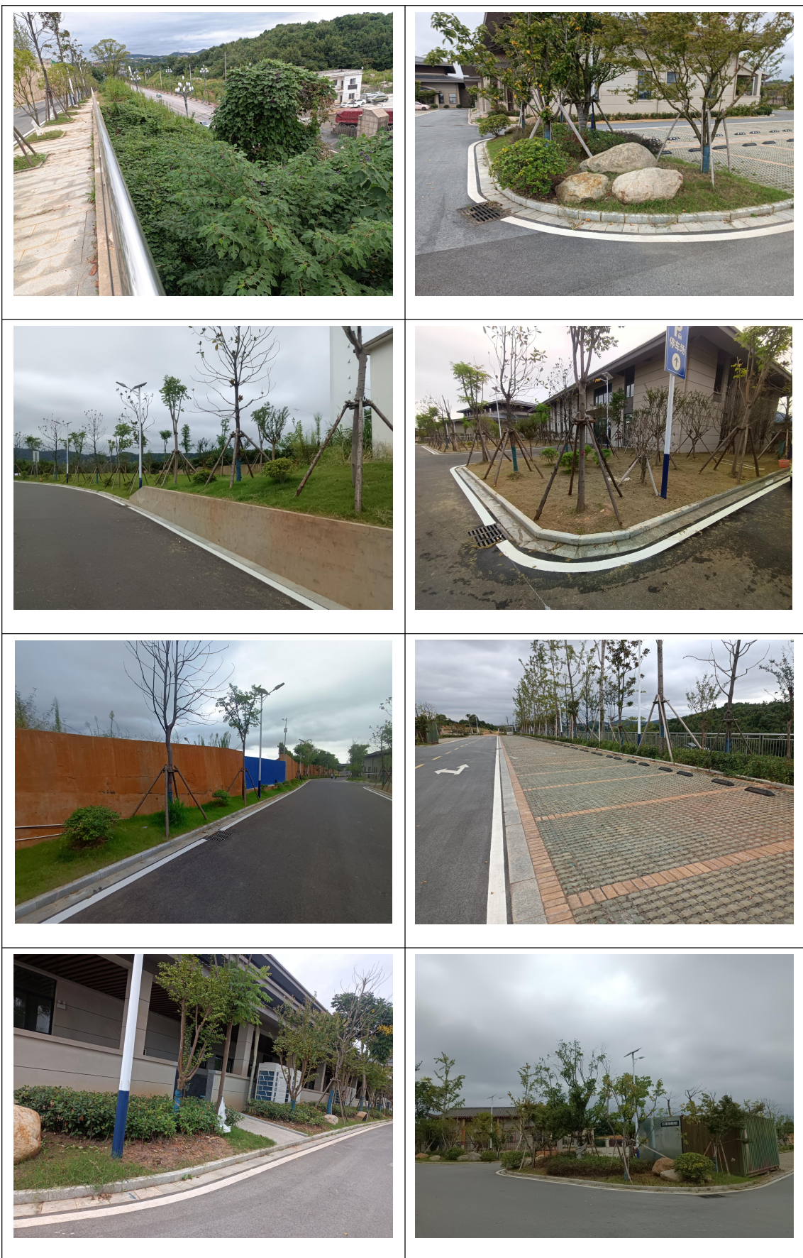
施工完成后影像
