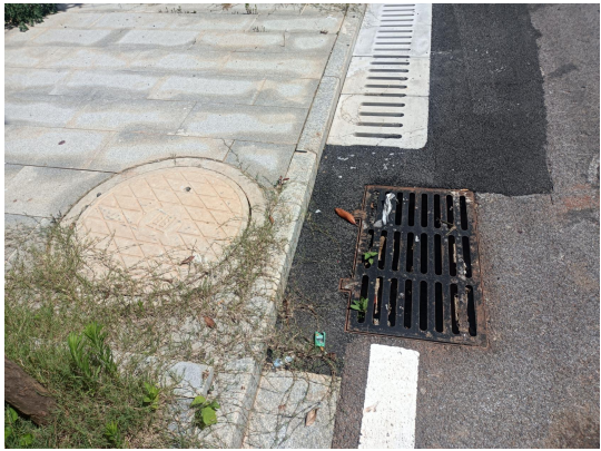
2023 年第三季度雨水口运行情况
