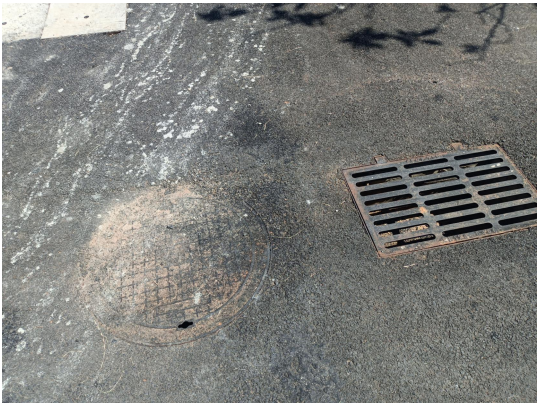
2023 年第三季度雨水口运行情况
