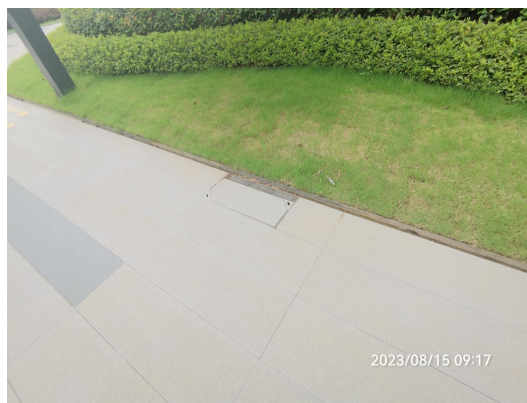
2023 年第三季度雨水口运行情况
