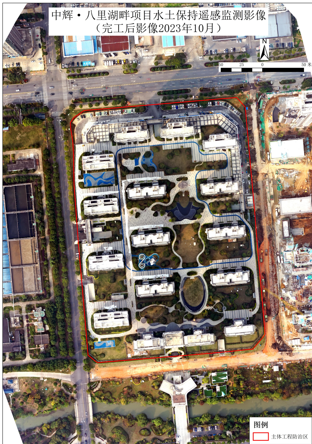
(2023年10月项目水土保持设施完成情况)
