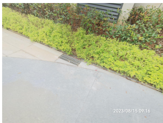
2023 年第三季度雨水口运行情况
