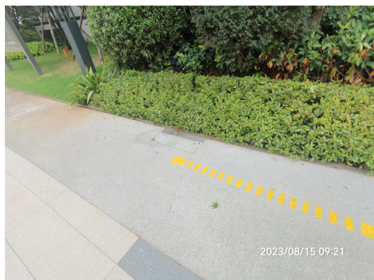
2023 年第三季度雨水口运行情况
