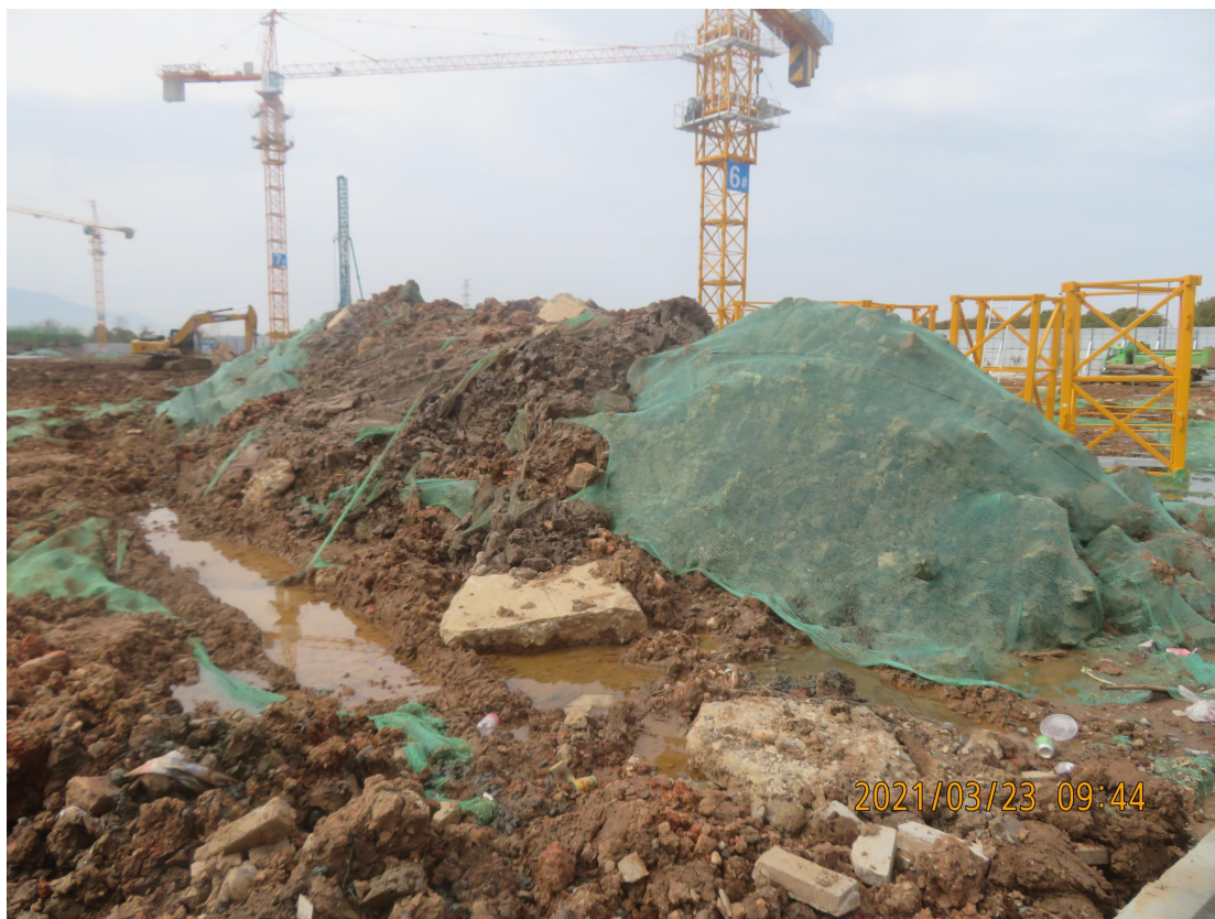
(施工过程中回填边坡及临时堆土重点监测部位)
