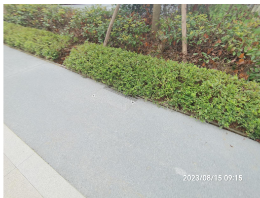
2023 年第三季度雨水口运行情况
