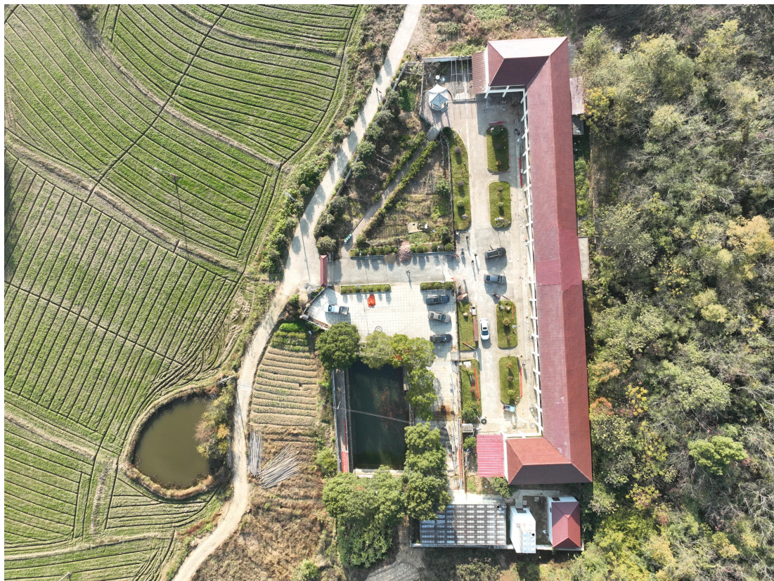
图1-3 武山镇养老院现状航拍图
