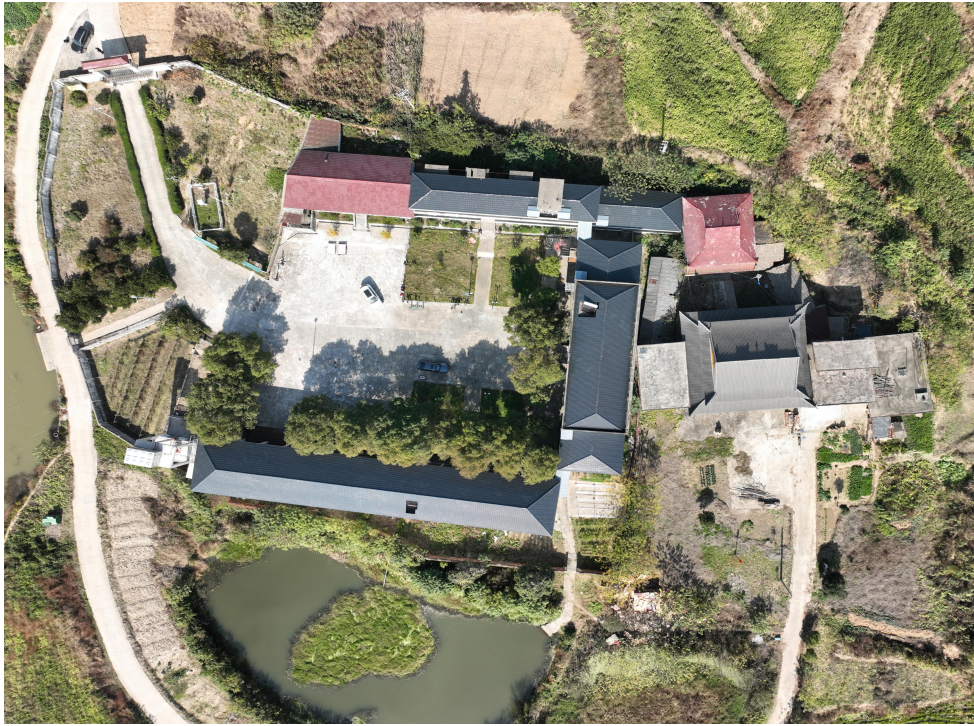
图1-1 城山镇养老院现状航拍图
