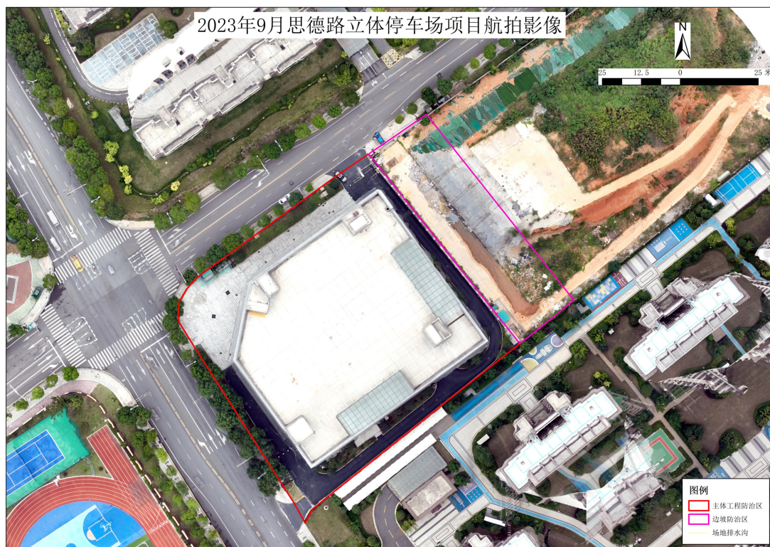
(2023年9月水土保持设施完成情况)
