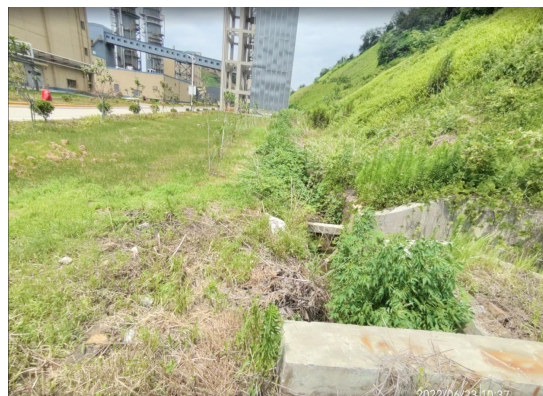
2022 年第二季度坡下排水沟运行情况
