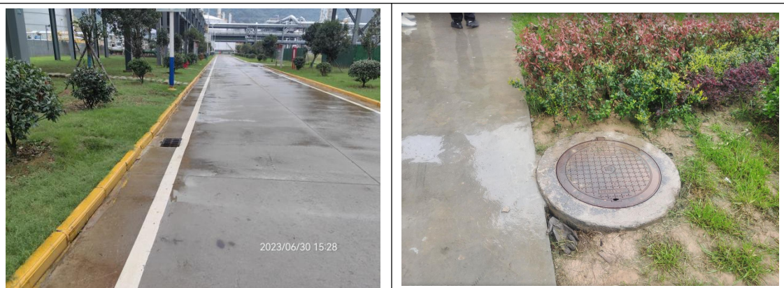
工程措施实施情况
