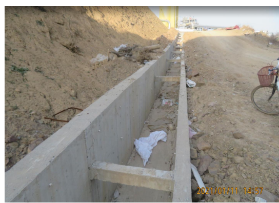
2021 年第一季度坡下排水沟运行情况
