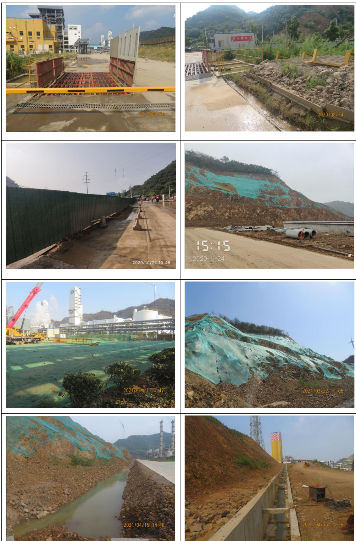
施工过程中影像
