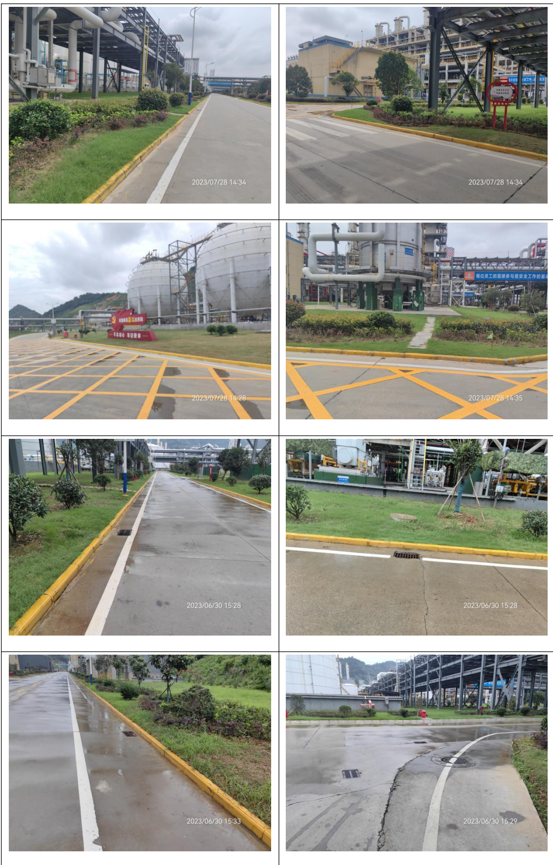
施工完成后影像
