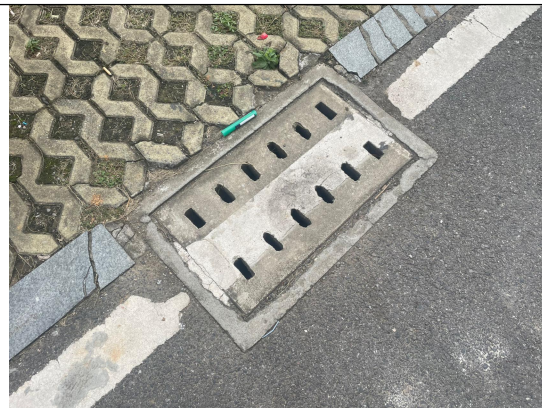
2023 年 9 月雨水口运行情况
