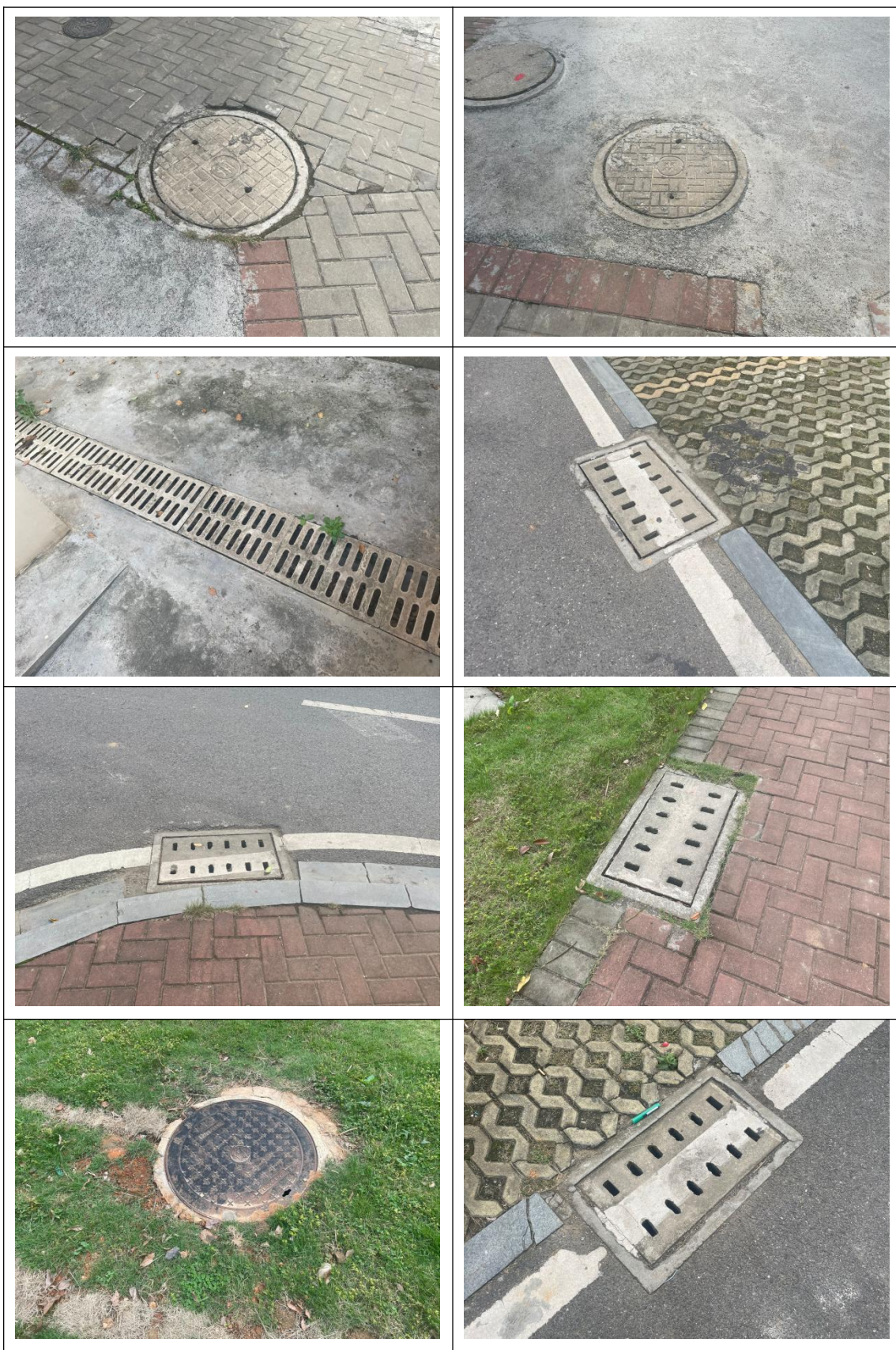
附件 7 重要水土保持单位工程照片
