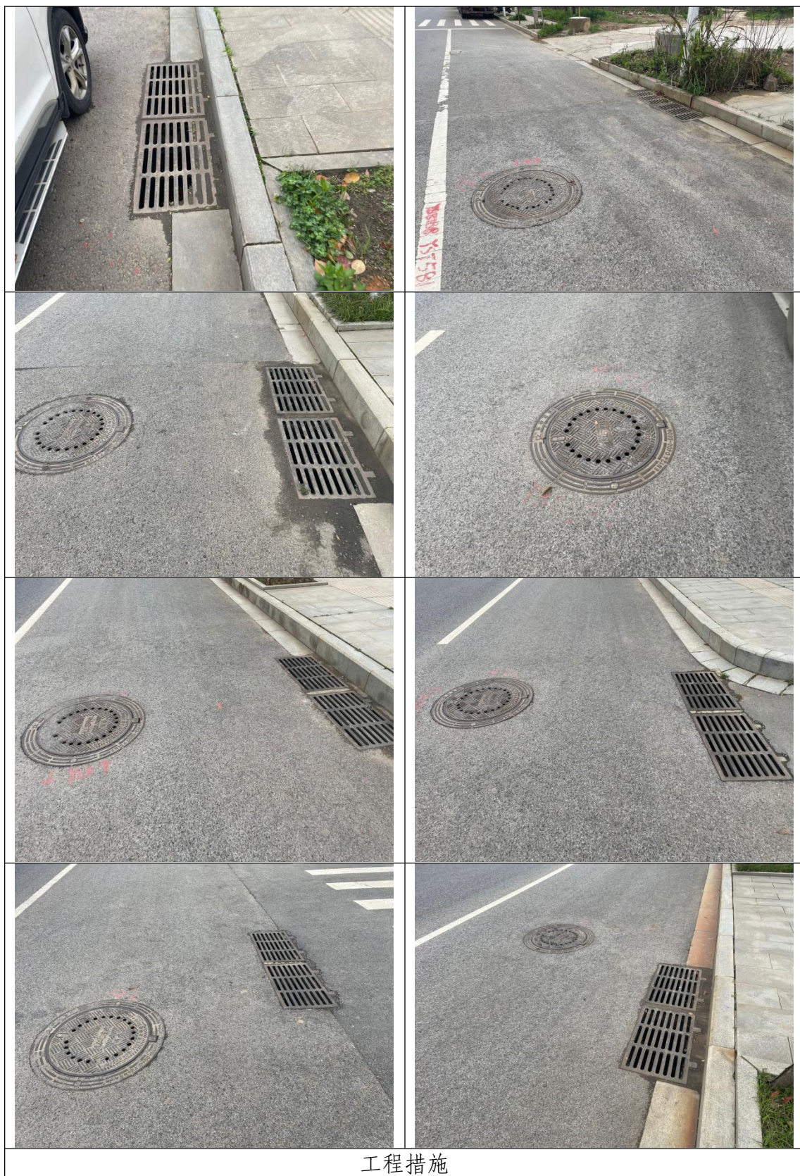
附件 5 重要水土保持单位工程照片
