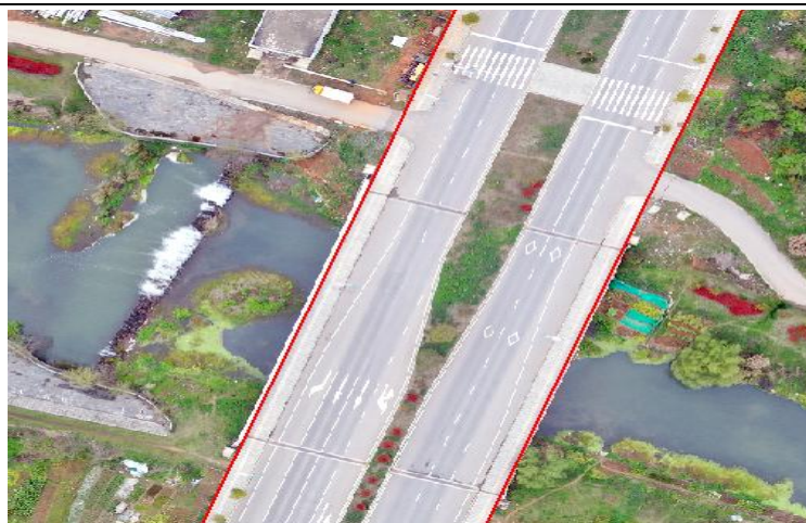
桥梁现场影像图
