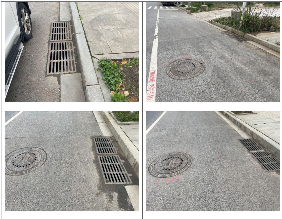
雨水口、雨水井运行情况
