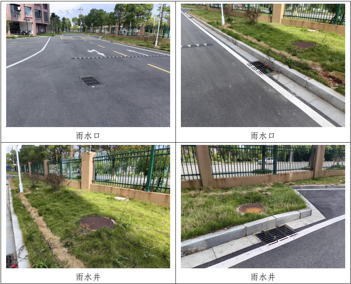
图 4.1-1 工程措施完成情况影像
