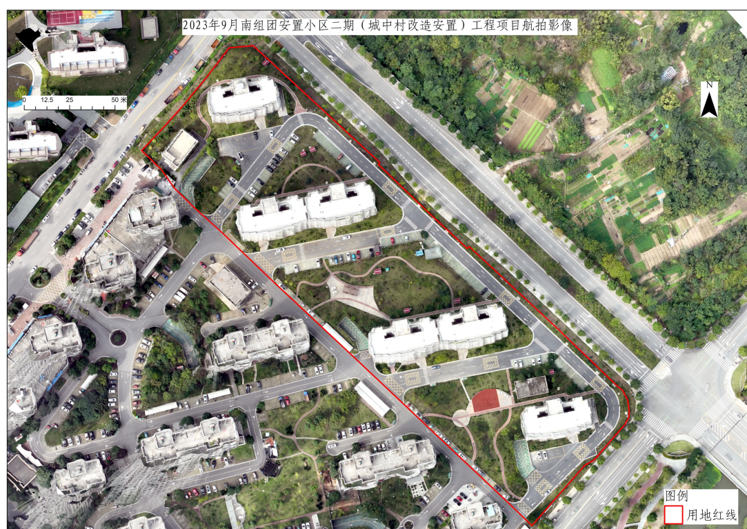
(2023 年 9 月项目水土保持设施完成情况)
