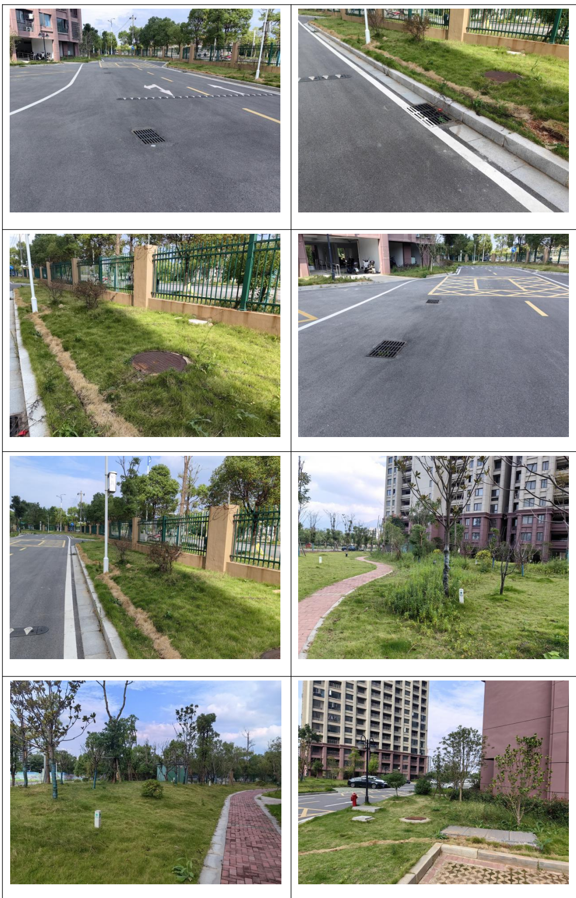
附件 6 重要水土保持单位工程照片
