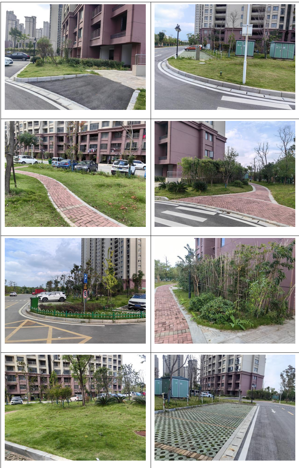
施工完成后影像
