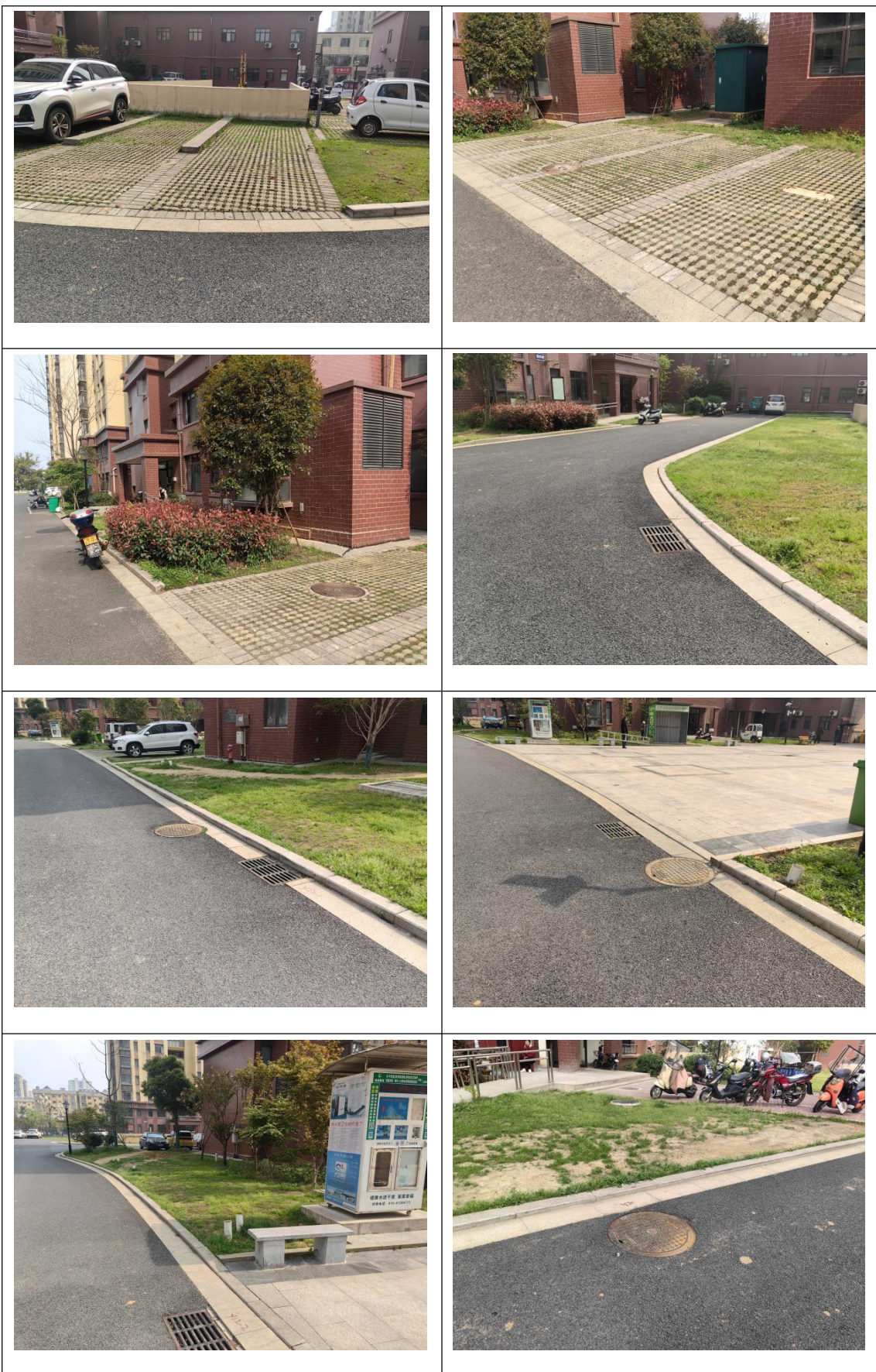
施工完成后影像
