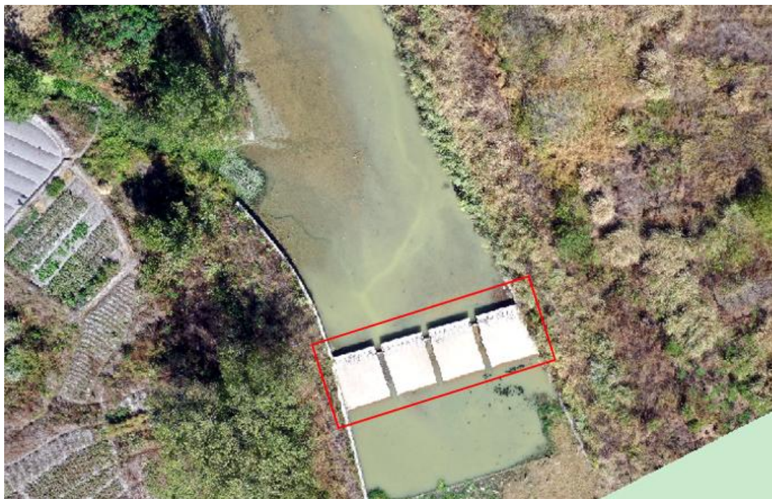
付家大堰照片
