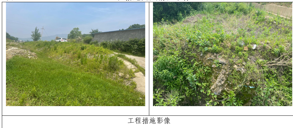
图 4.1-1 工程措施完成情况影像
