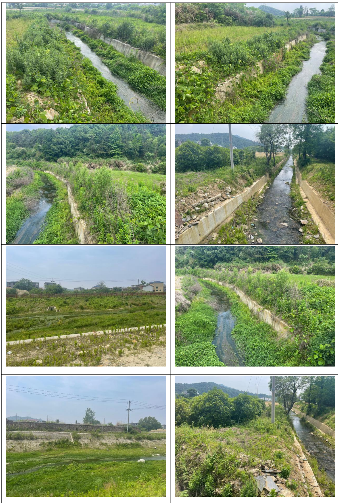
附件 7 重要水土保持单位工程照片
