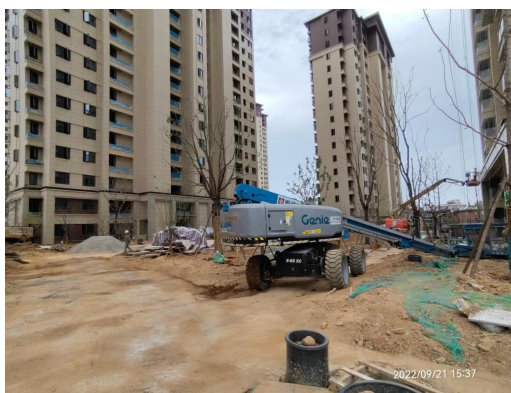
2022 年第三季度绿化施工
