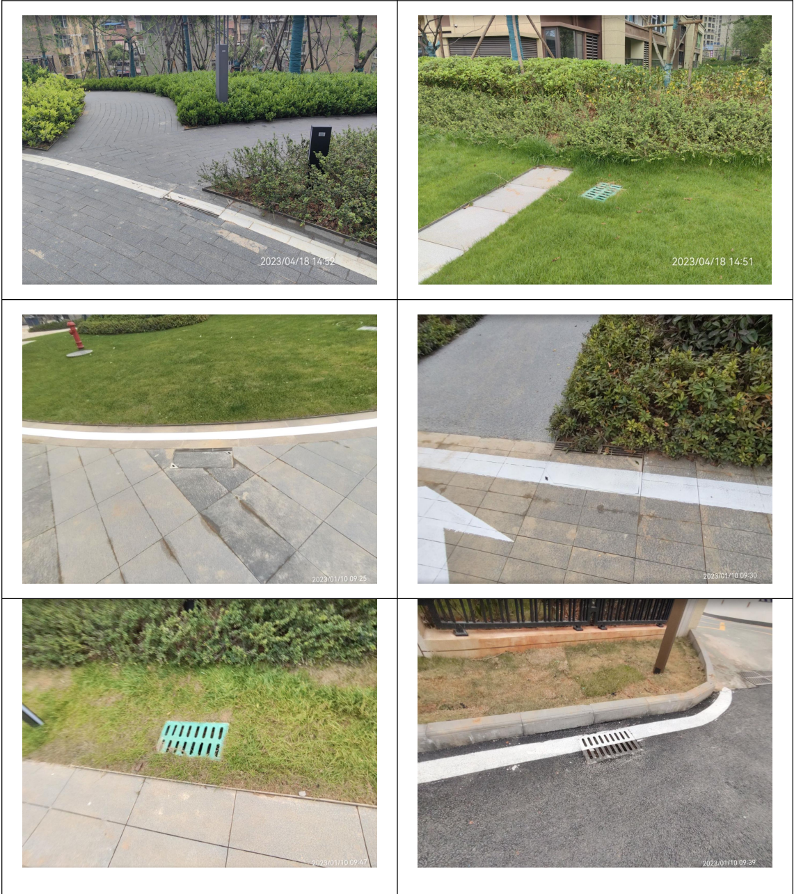
图 4.1-1 工程措施完成情况影像
