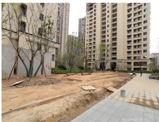
2022 年第三季度绿化施工
