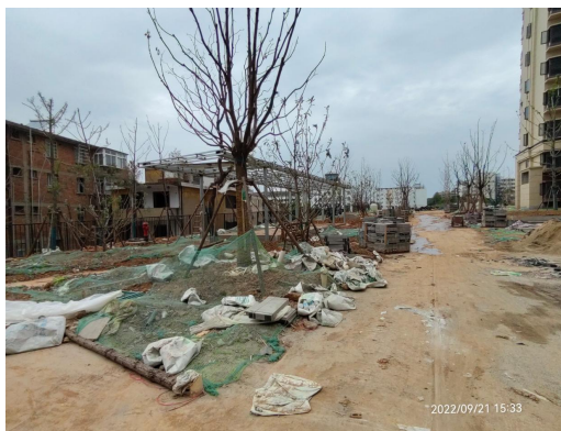
2022 年第三季度绿化施工
