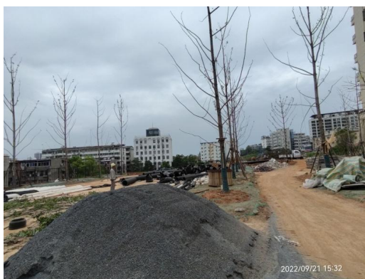
2022 年第三季度绿化施工
