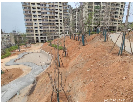
2022 年第三季度绿化施工
