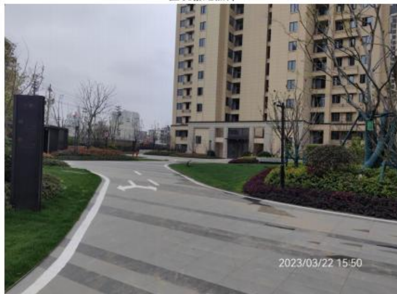
整改措施照片
