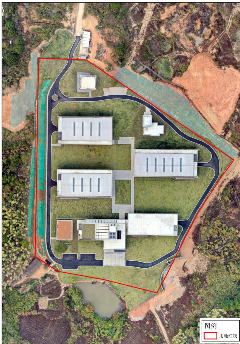
中海庐山西海A1-1地块主题酒店项目航拍影像（2022年11月）
