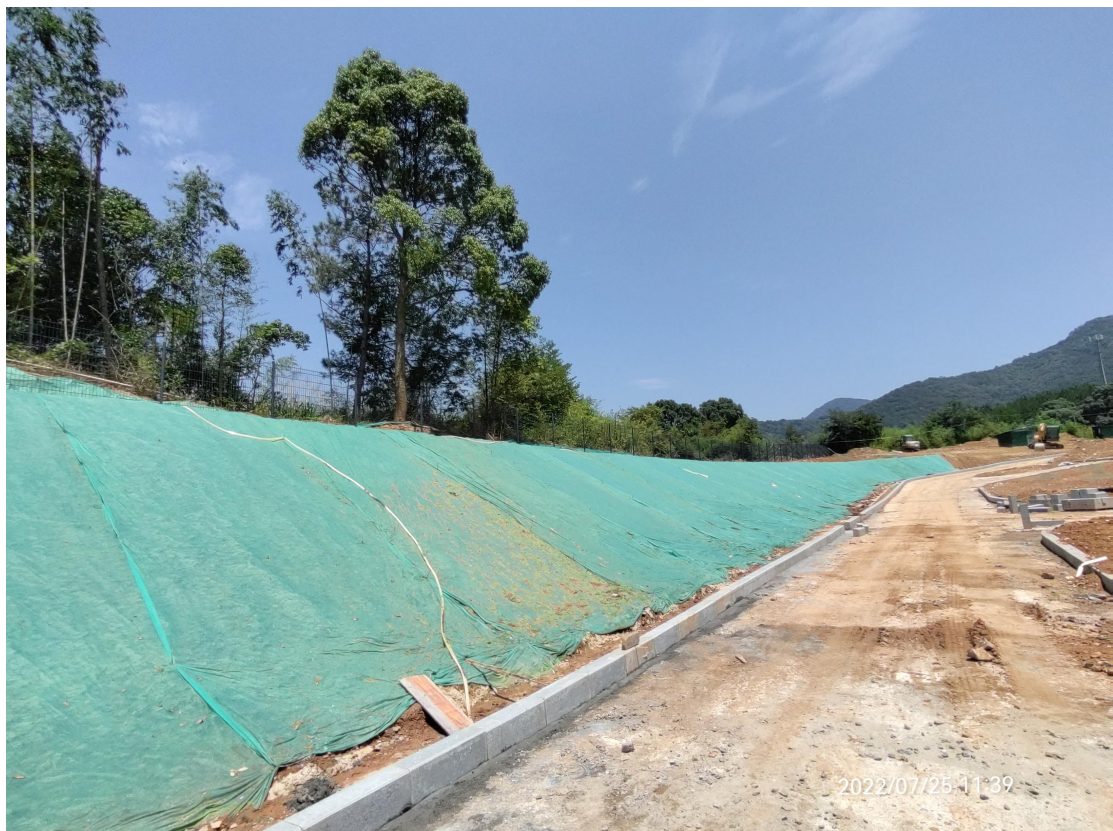
(施工过程中边坡区域重点监测部位)
