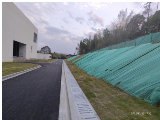
2022 年第四季度排水沟运行情况
