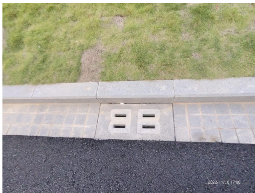
2022 年第四季度雨水口运行情况
