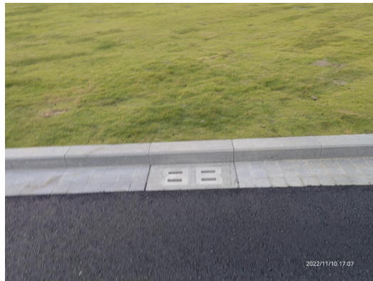
2022 年第四季度雨水口运行情况
