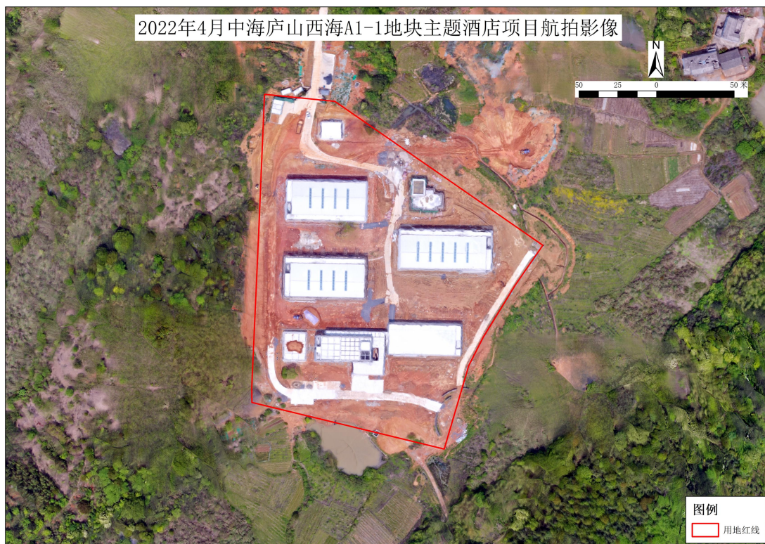
(2022年4月项目现状航测)
