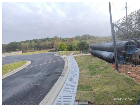
2022 年第四季度排水沟运行情况
