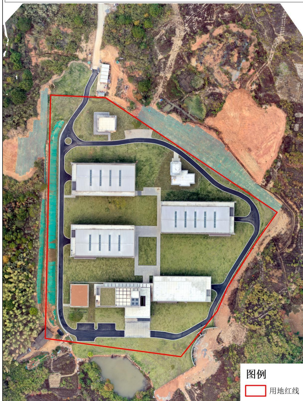
中海庐山西海A1-1地块主题酒店项目一期水土保持遥感监测影像 (完工后影像2023年2月)
