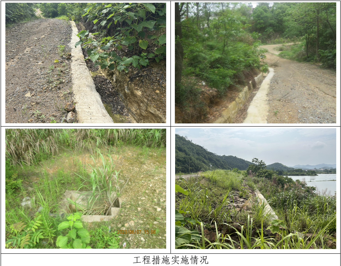
图 4.1-1 工程措施完成情况影像
