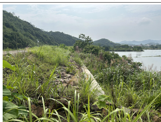
2023 年第二季度干砌石护坡运行情况
