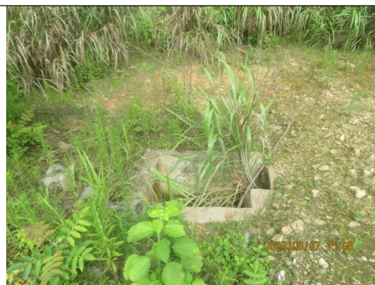
2023 年第二季度沉沙池运行情况
