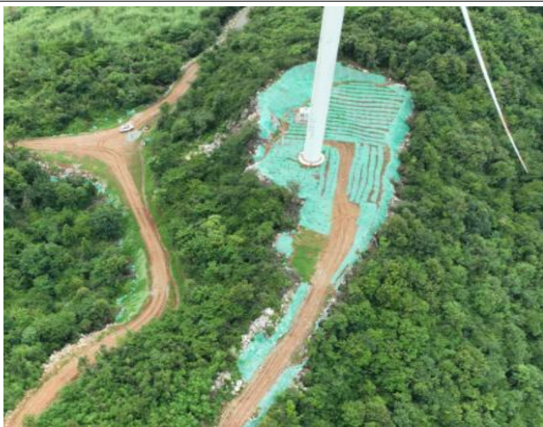
BJ2#风机平台（水土保持措施施工前、后对比影像）
