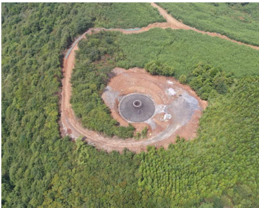
2022 年 8 月，2#平台水保工程建设前影像
