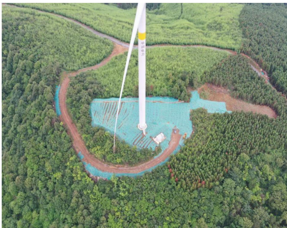
2023 年 5 月，2#平台水保工程建设后初期运行效果影像
