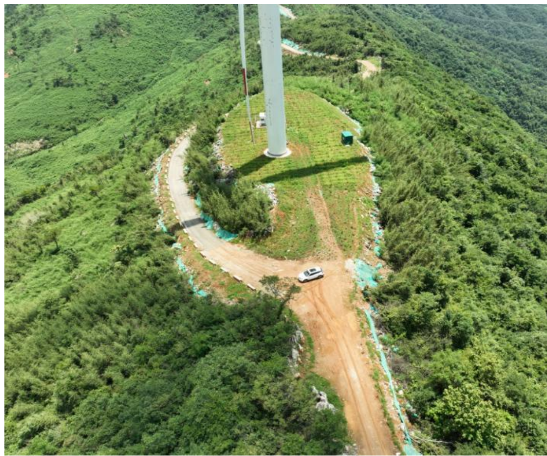
BJ6#风机平台（水土保持措施施工前、后对比影像）
