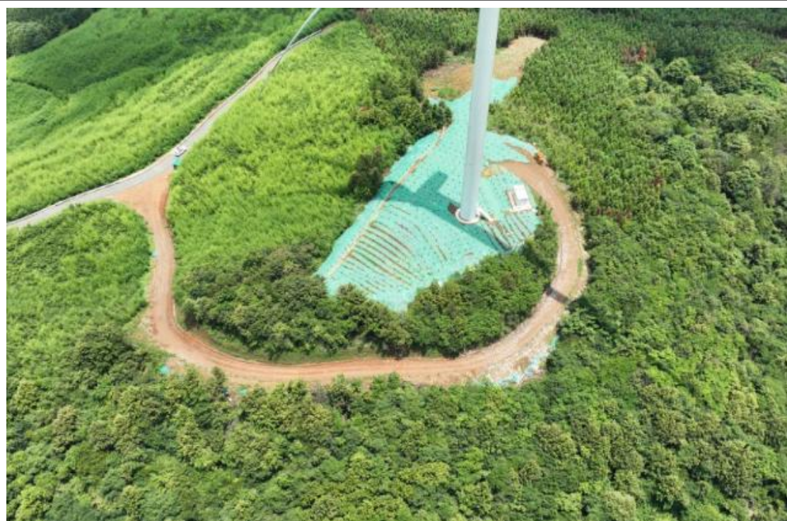
BJ5#风机平台（水土保持措施施工前、后对比影像）
