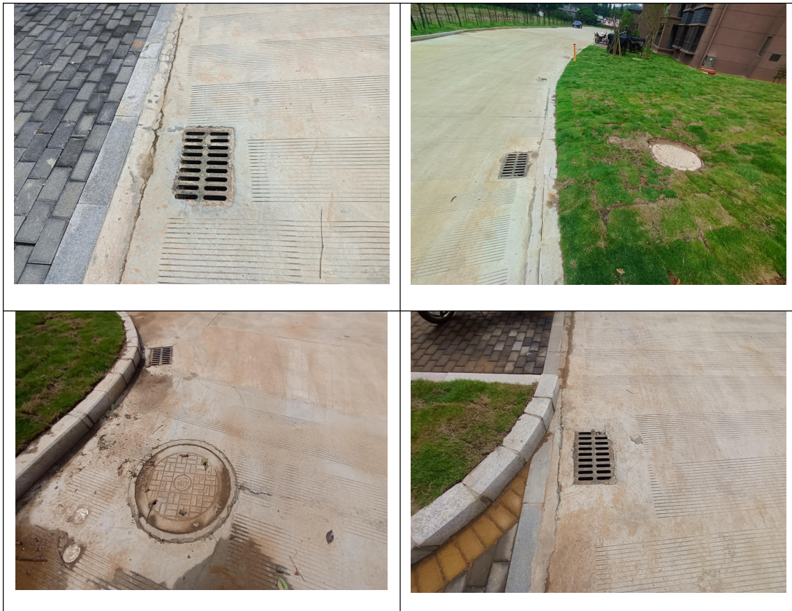
雨水口雨水井运行情况
