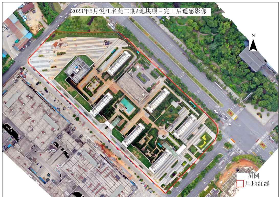
(2023 年 5 月项目水土保持设施完成情况)
