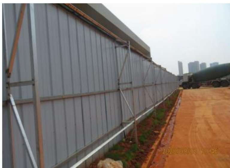
临时围挡及场地排水沟
