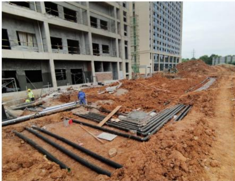
雨水管网施工中
