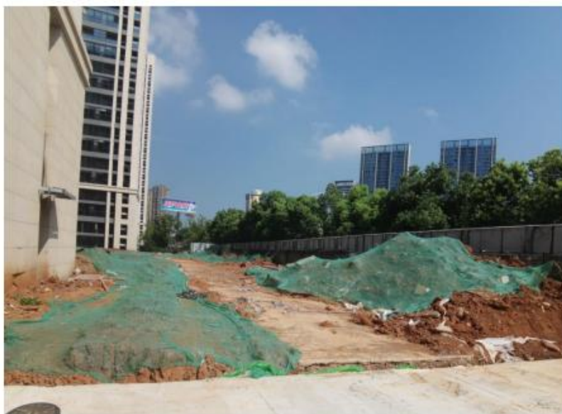
苫布覆盖及临时围挡
