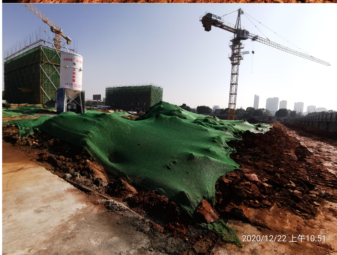
(基础、地下室开挖、临时堆土防护)
