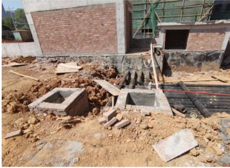
雨水管网施工中
