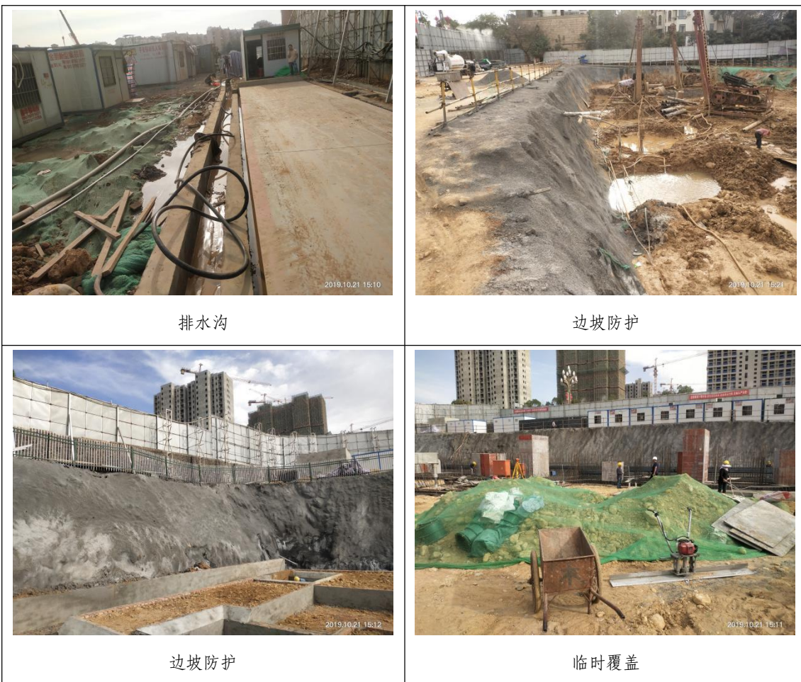
临时措施影像
