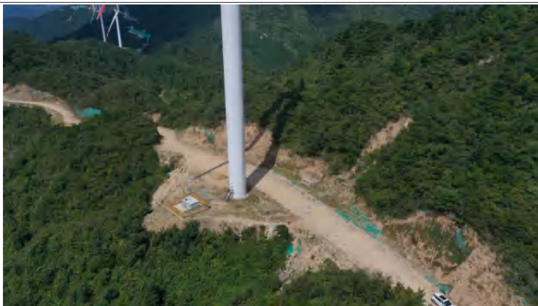
7#风机平台（水土保持工程措施施工前、后对比影像）
