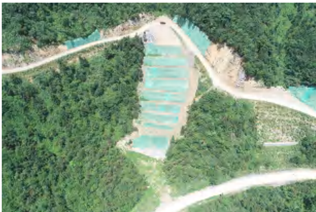
2019 年 6 月，9#弃土场护坡工程建设前坡面影像
