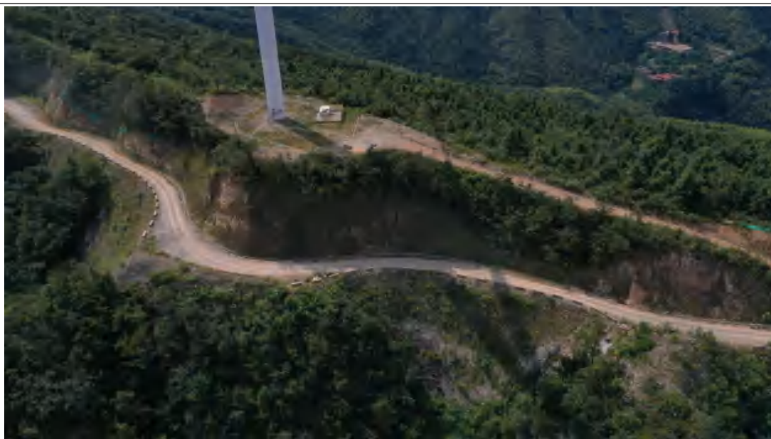
24#风机平台（水土保持工程措施施工前、后对比影像）
