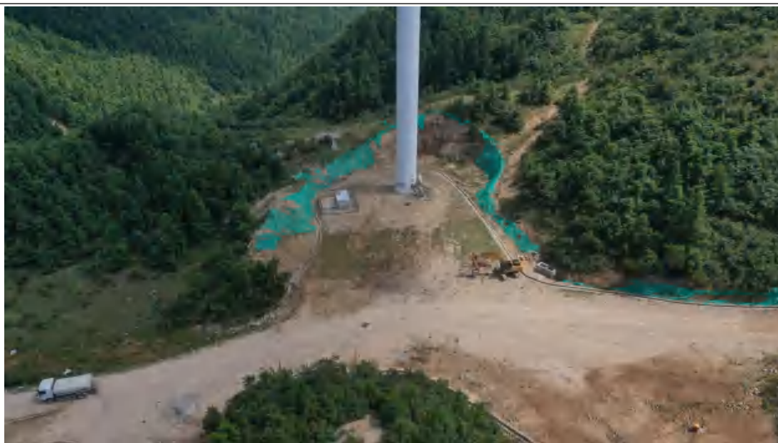
9#风机平台（水土保持工程措施施工前、后对比影像）
