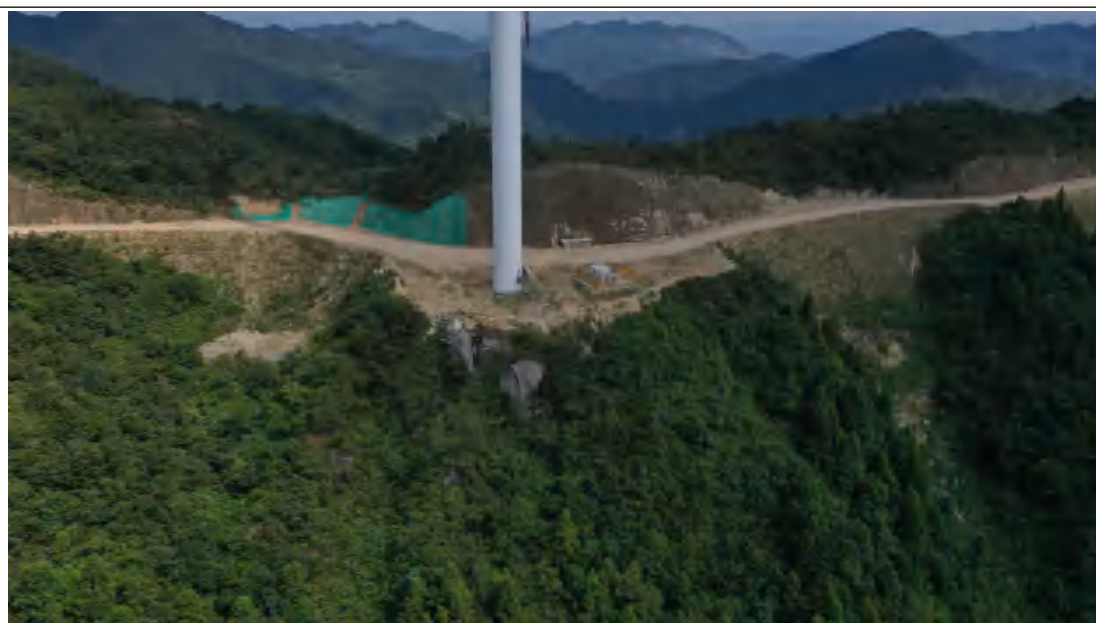
15#风机平台（水土保持工程措施施工前、后对比影像）
