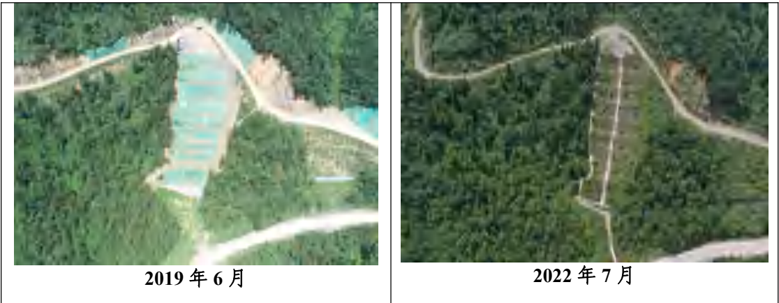
工程措施监测点（1）
