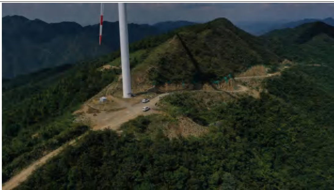
21#风机平台（水土保持工程措施施工前、后对比影像）
