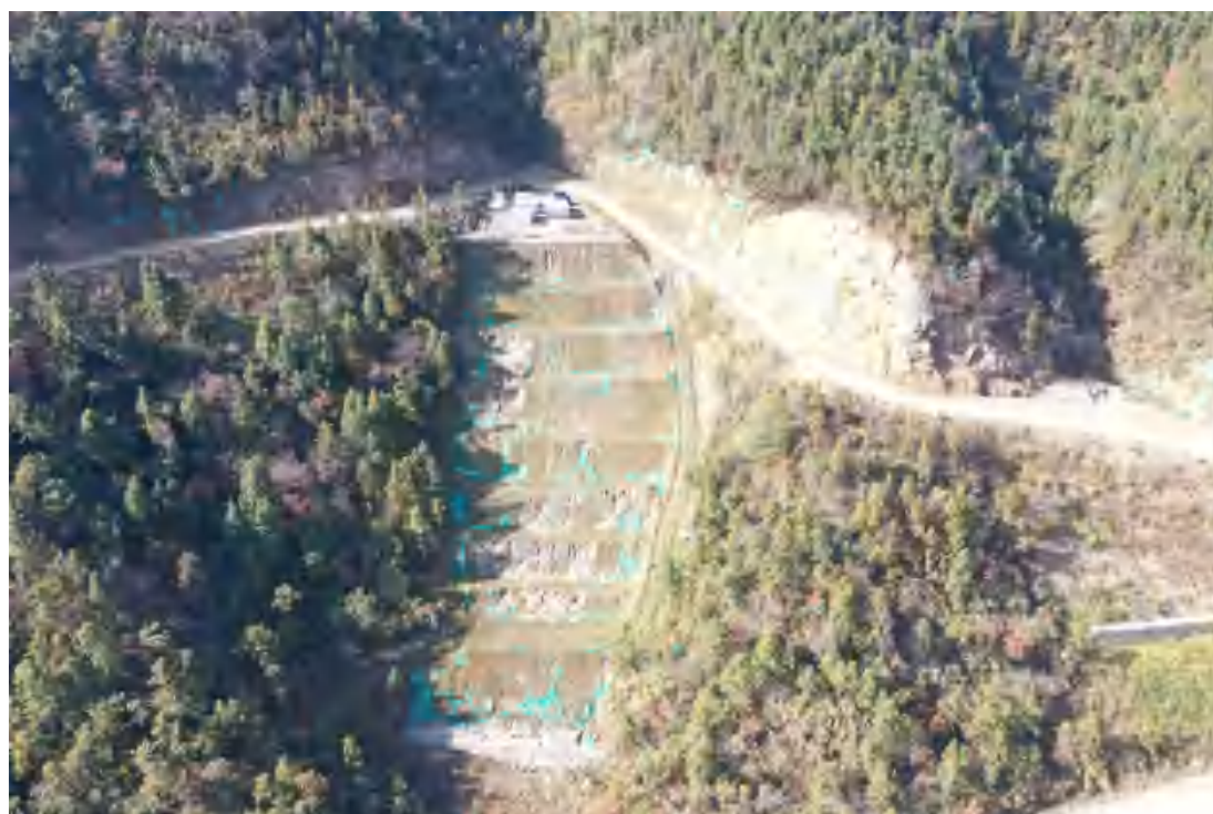
2019 年 11 月，9#弃土场护坡工程建设中坡面防治情况影像
