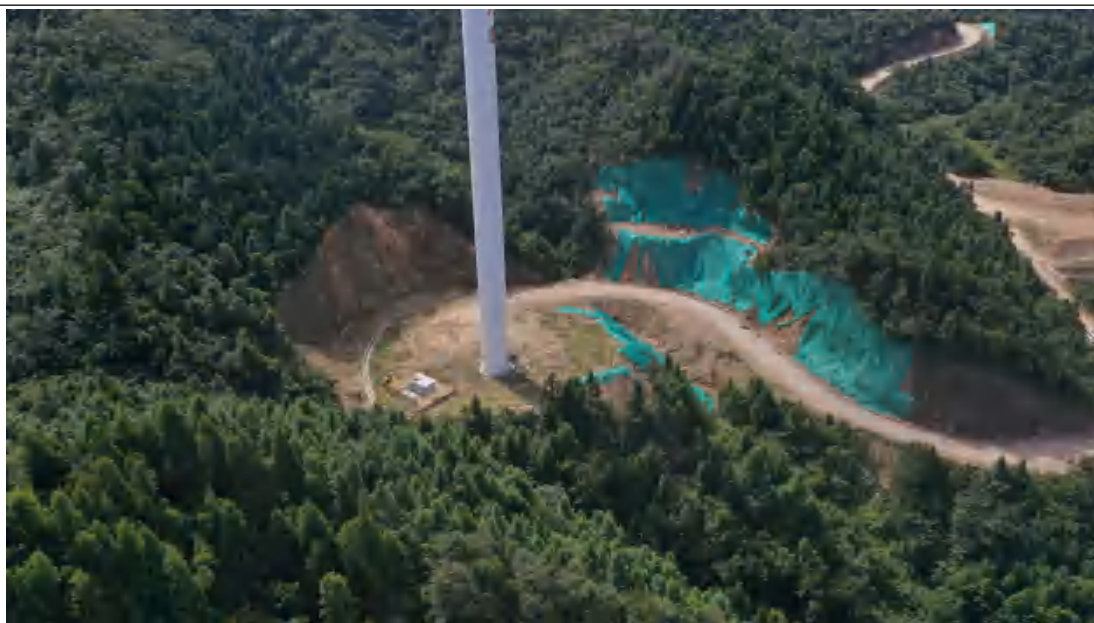
18#风机平台（水土保持工程措施施工前、后对比影像）
