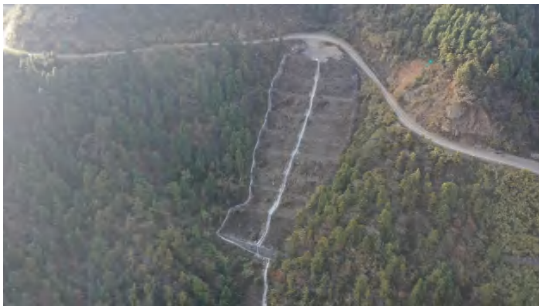
2022 年 12 月，9#弃土场护坡工程初期运行效果影像
