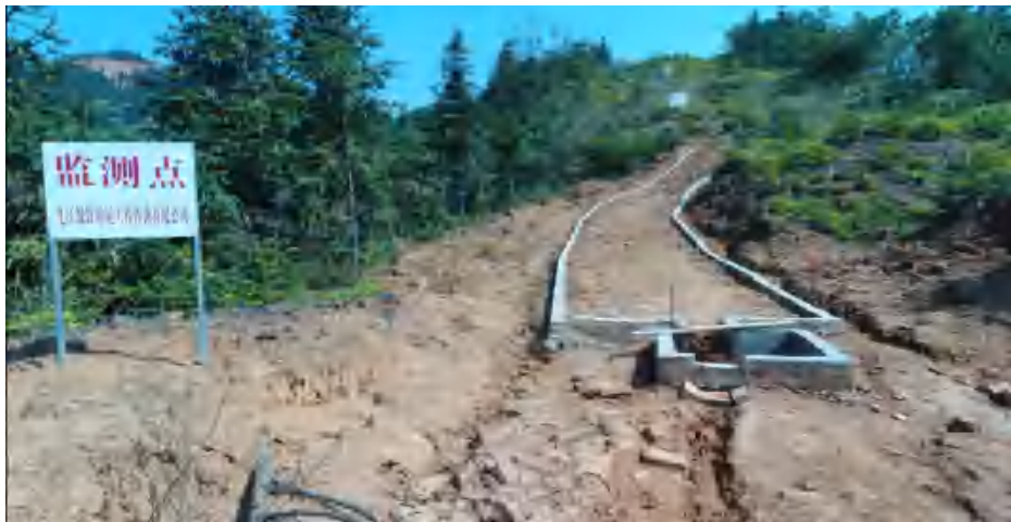
土壤流失量监测点
