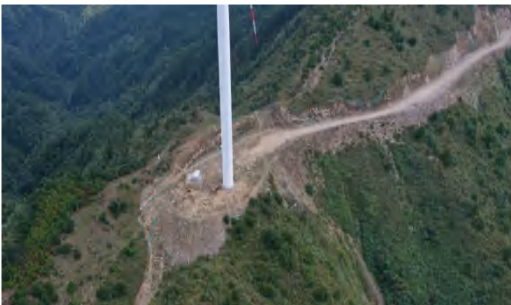
1#风机平台（水土保持工程措施施工前、后对比影像）
