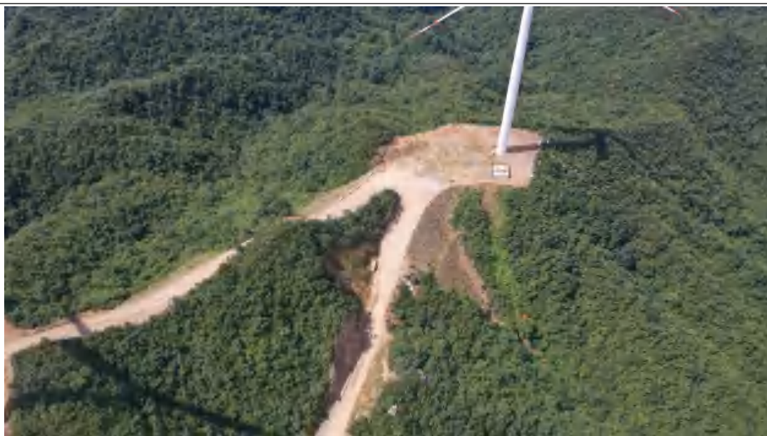
4#风机平台（水土保持工程措施施工前、后对比影像）
