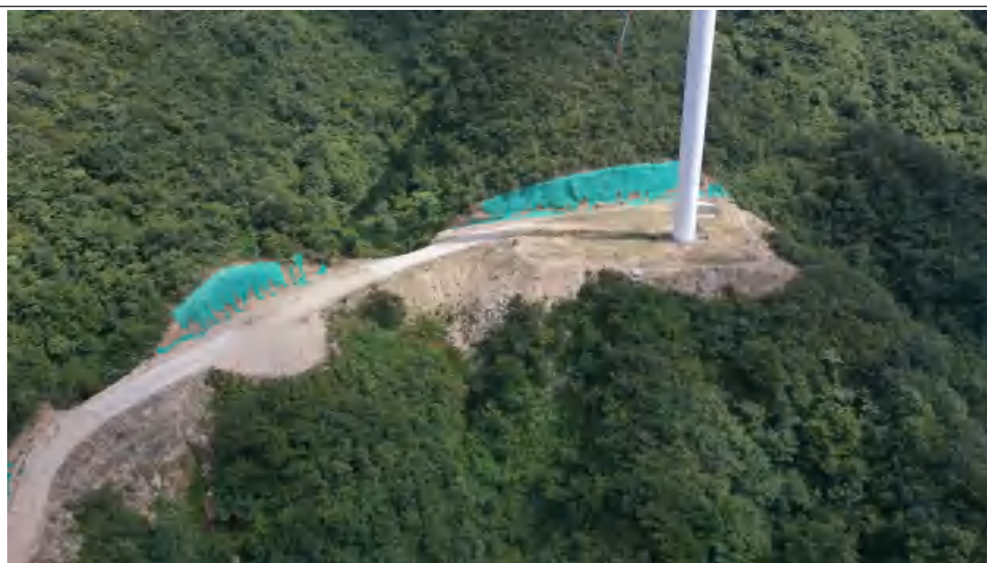
11#风机平台（水土保持工程措施施工前、后对比影像）
