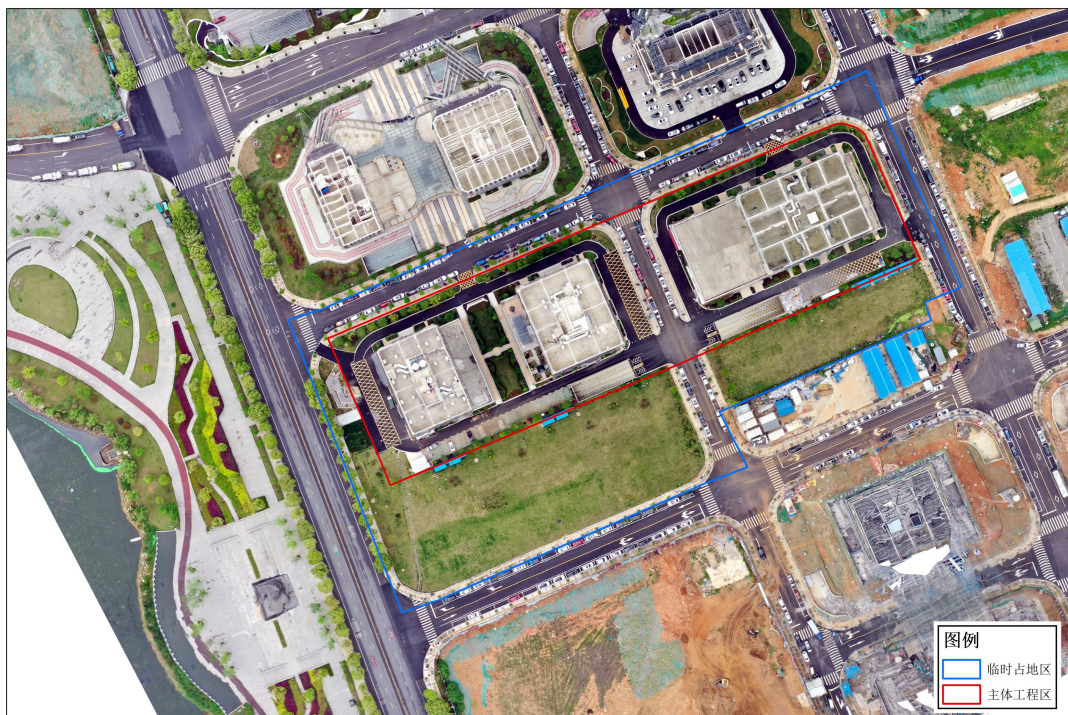
徽商商务中心项目完工后航测影像（2023年3月）
