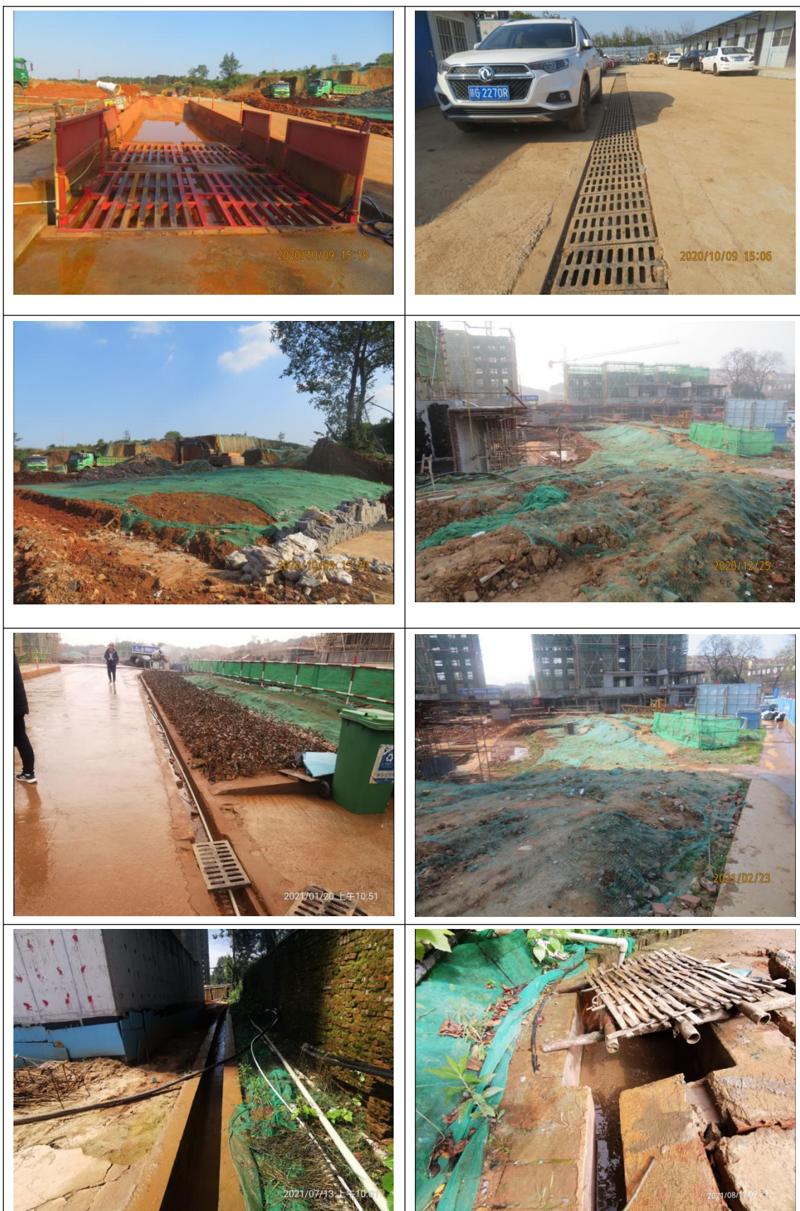
施工过程中水土保持设施影像资料
