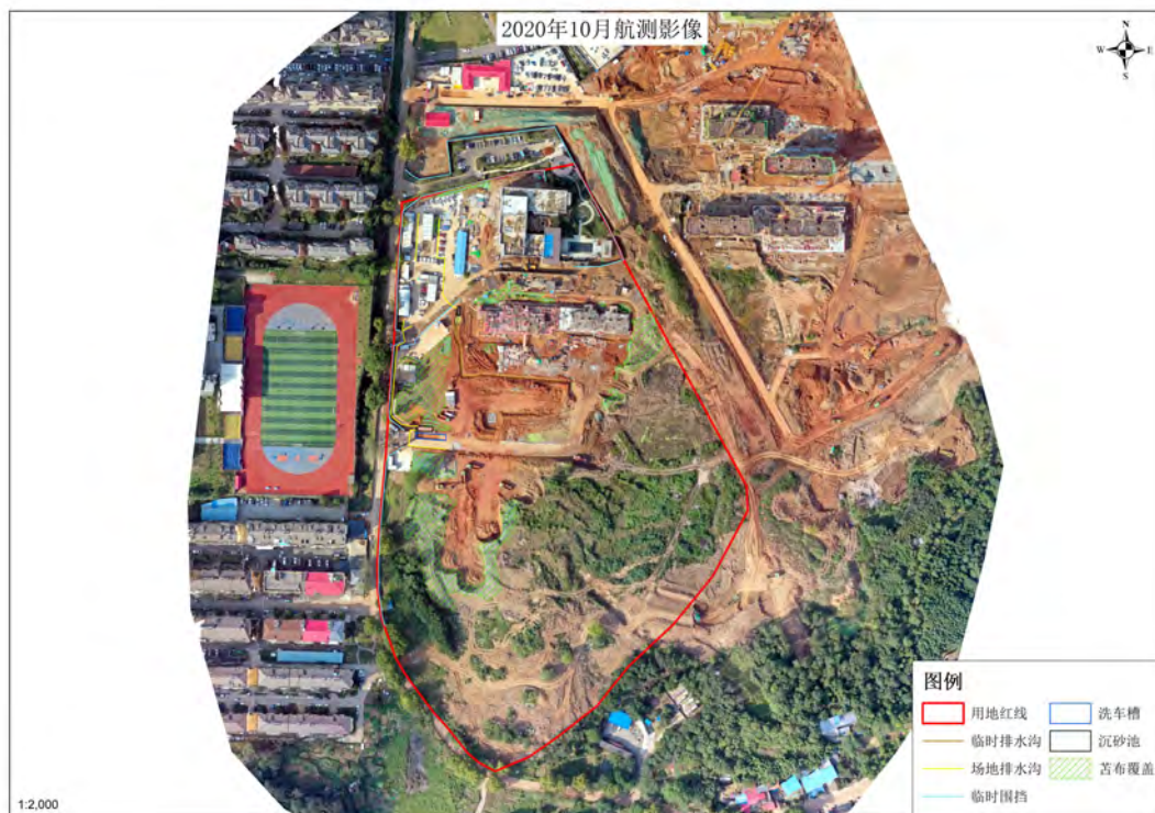
(2020年10月主体工程区现状航测)
