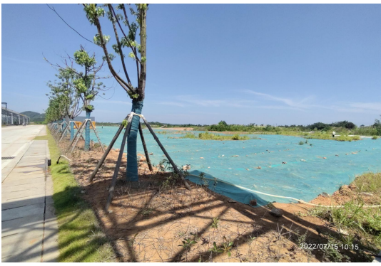
撒播草籽、临时覆盖
