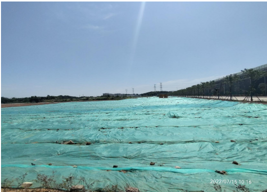
撒播草籽、临时覆盖
