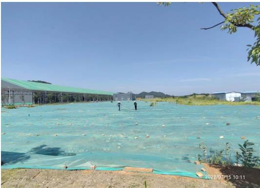
撒播草籽、临时覆盖
