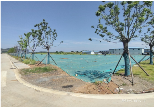
撒播草籽、临时覆盖
