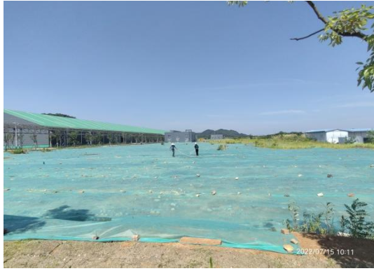
撒播草籽、临时覆盖
