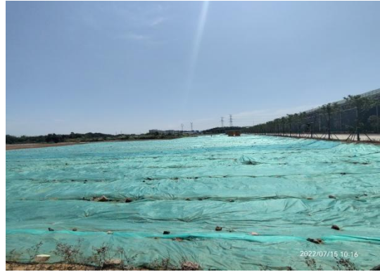
撒播草籽、临时覆盖
