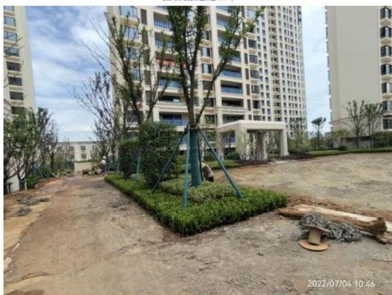
植物措施施工中
