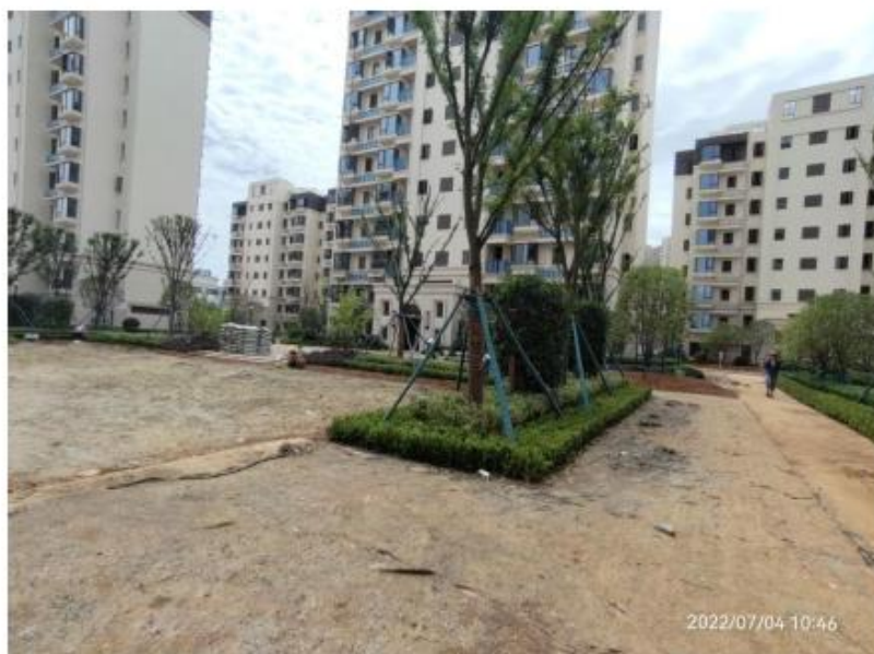
植物措施施工中
