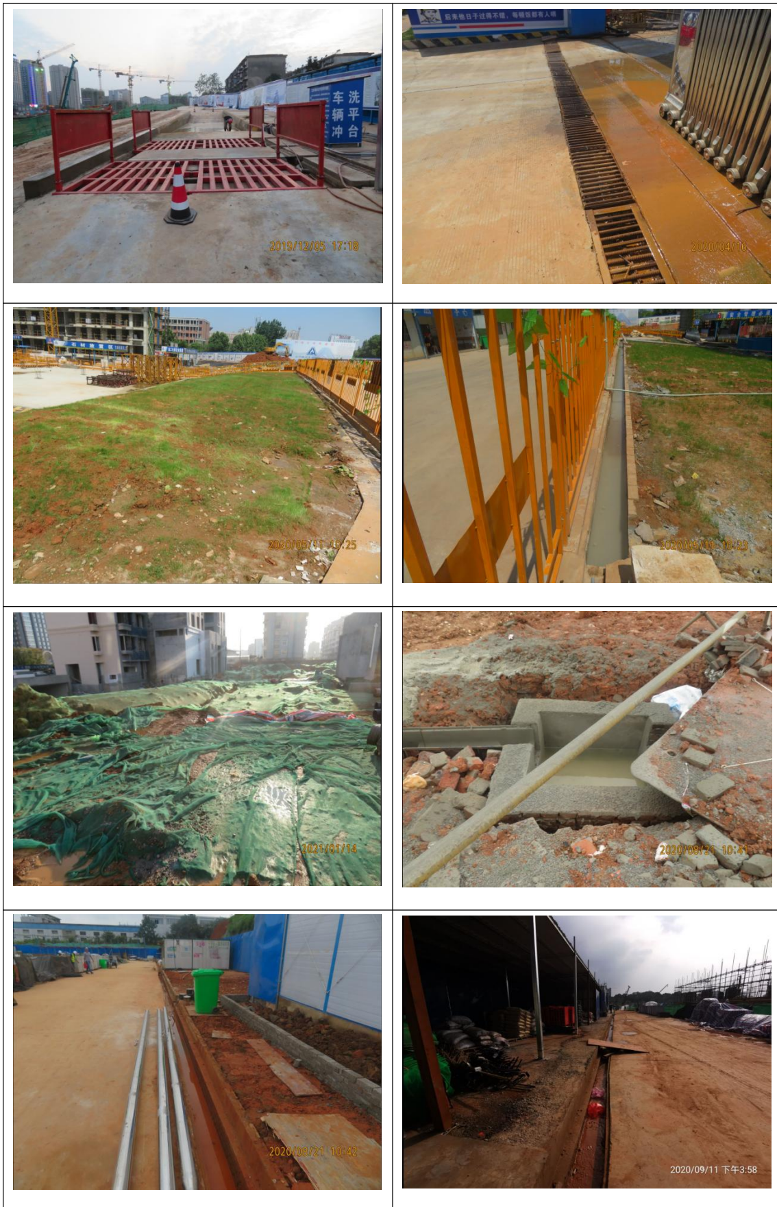
附件 6 重要水土保持单位工程照片
