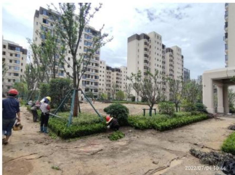
植物措施施工中
