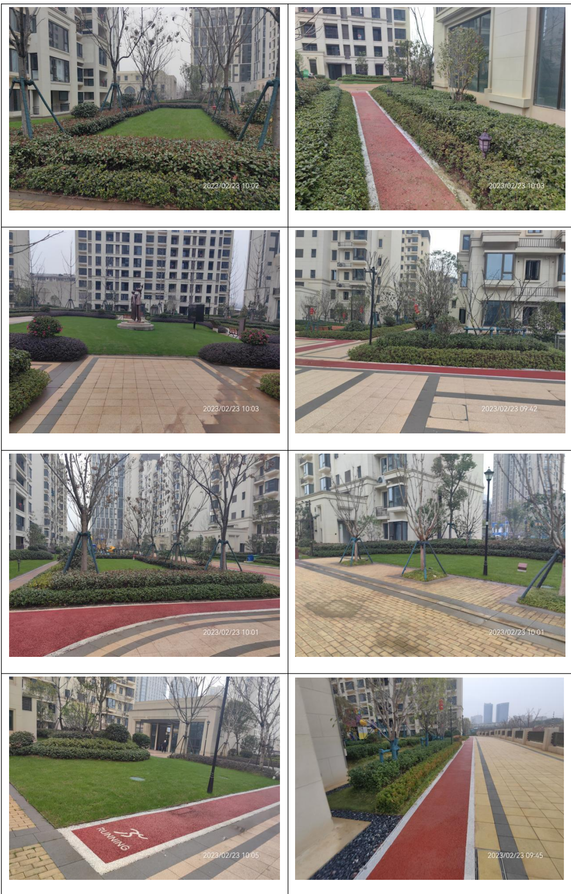
施工完成后影像
