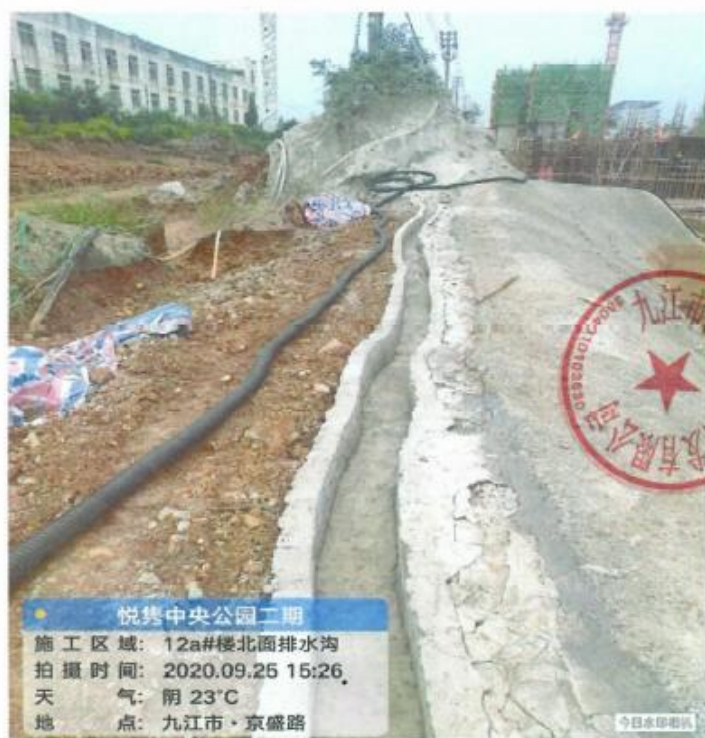
现场排水沟整改后照片
