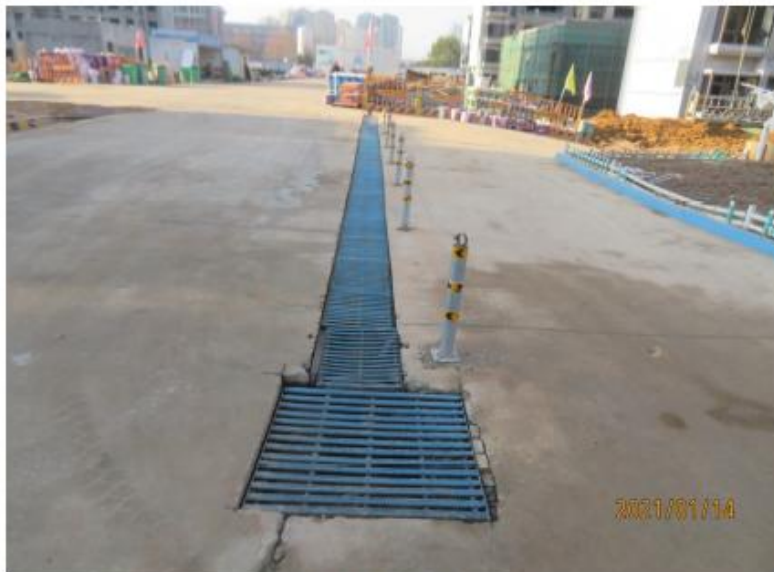
排水沟、沉砂池
