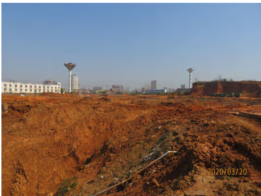
(施工过程中基础开挖重点监测部位)
