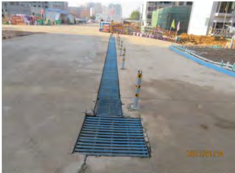
排水沟、沉砂池
