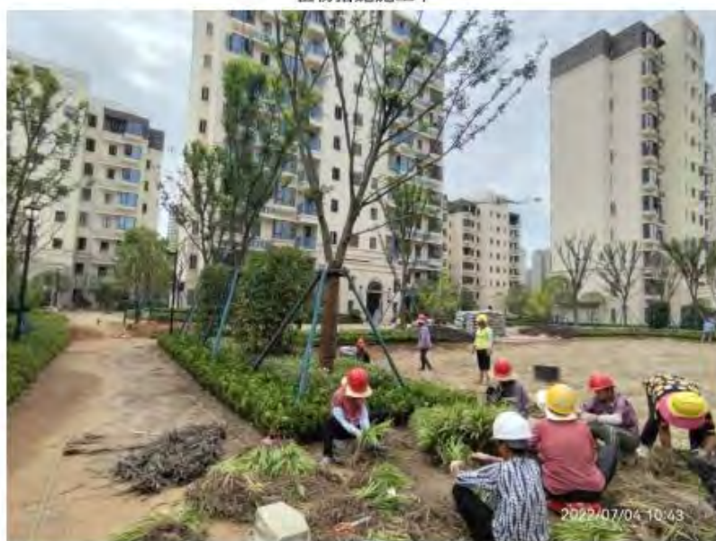
植物措施施工中
