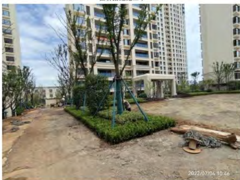
植物措施施工中
