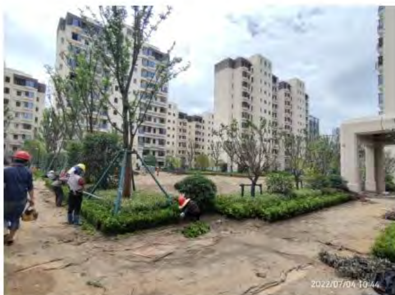
植物措施施工中
