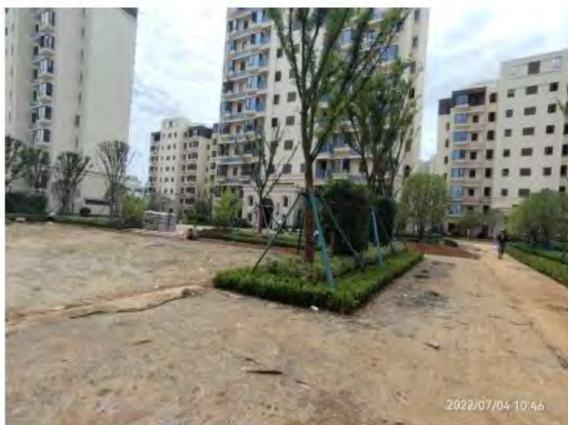
植物措施施工中
