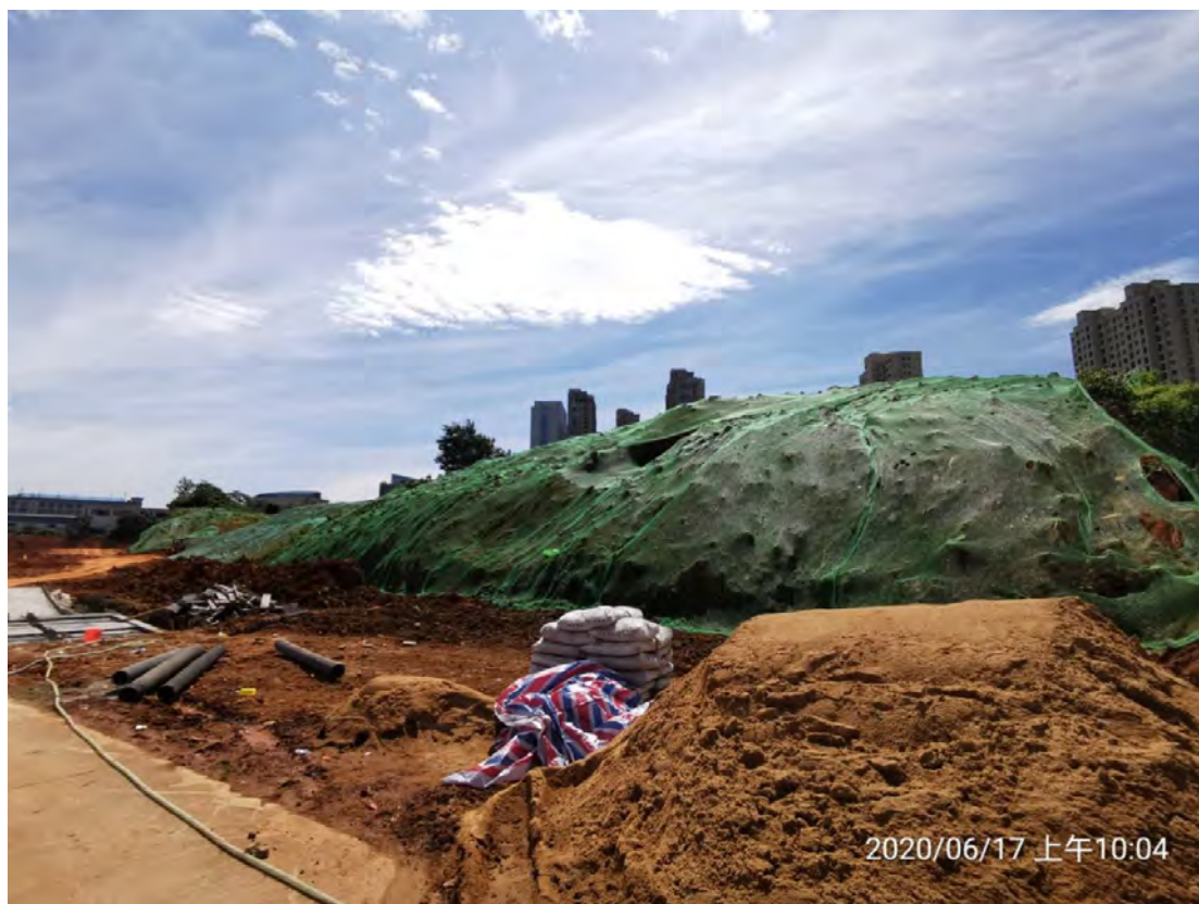
(施工过程中临时堆土重点监测部位)
