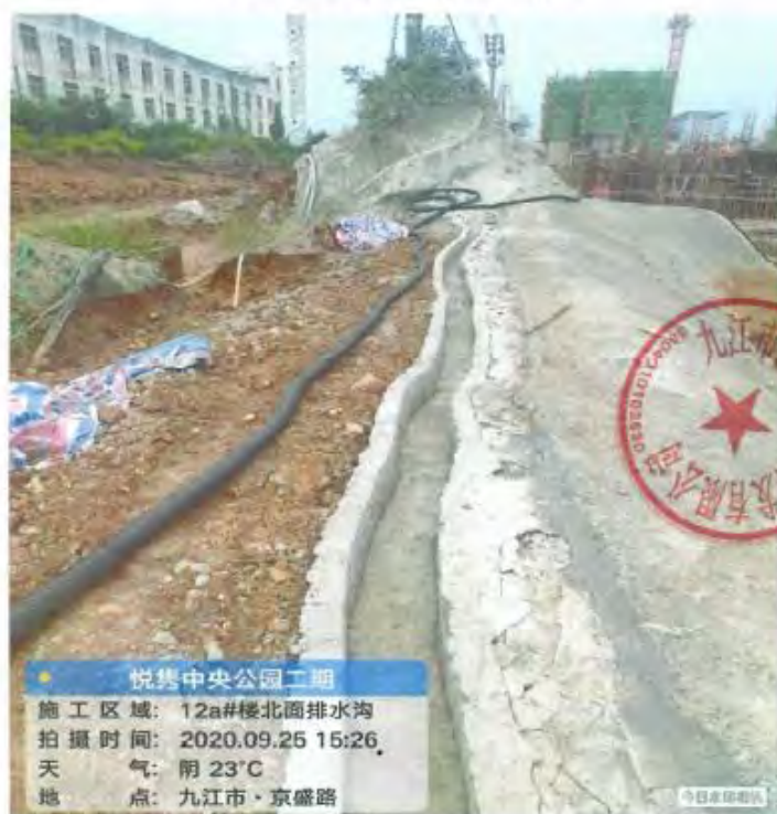
现场排水沟整改后照片
