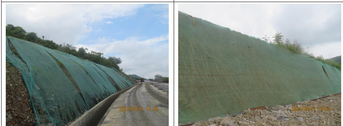
排水沟、临时覆盖
