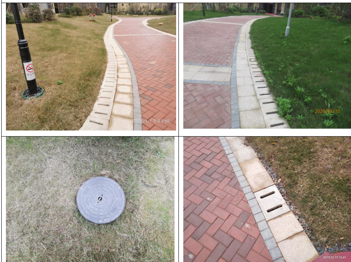
各防治区雨水井雨水口运行情况
