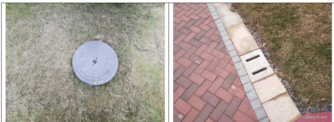
各防治区雨水井雨水口运行情况
