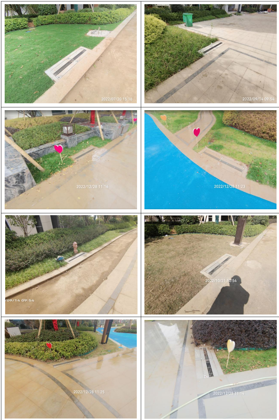
附件 6 重要水土保持单位工程照片
